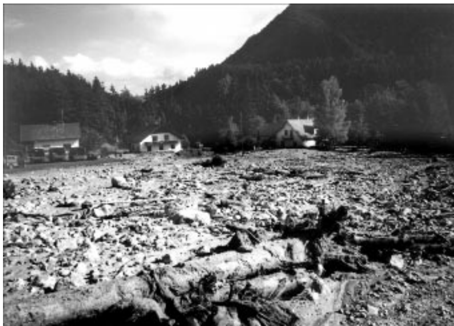
Abb. 9. Murenmaterial aus Baumbruchwerk, das sich vom Toningraben aus über die Landesstraße Richtung Waidisch ergoss.
