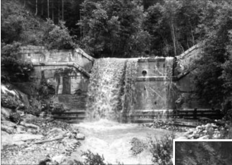
Abb. 15. Holzvorboden, auf dem die alte Sperre aufsitzt.
