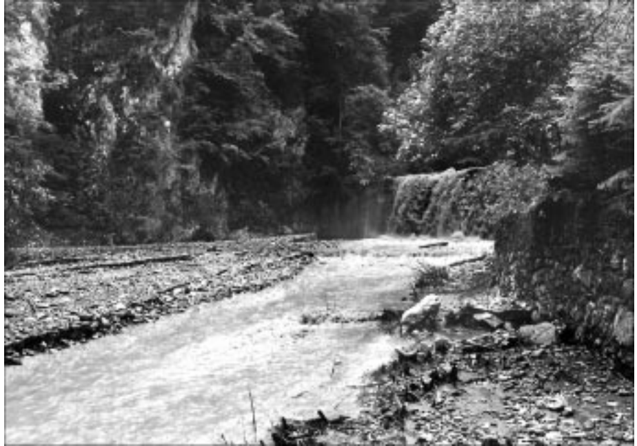
Abb. 12. Vorderbergerbach, Bänderkalke im Vordergrund bei der ersten Sperre. Einbindung des Sperrenfußes in braune, glimmerreiche Schiefer.
