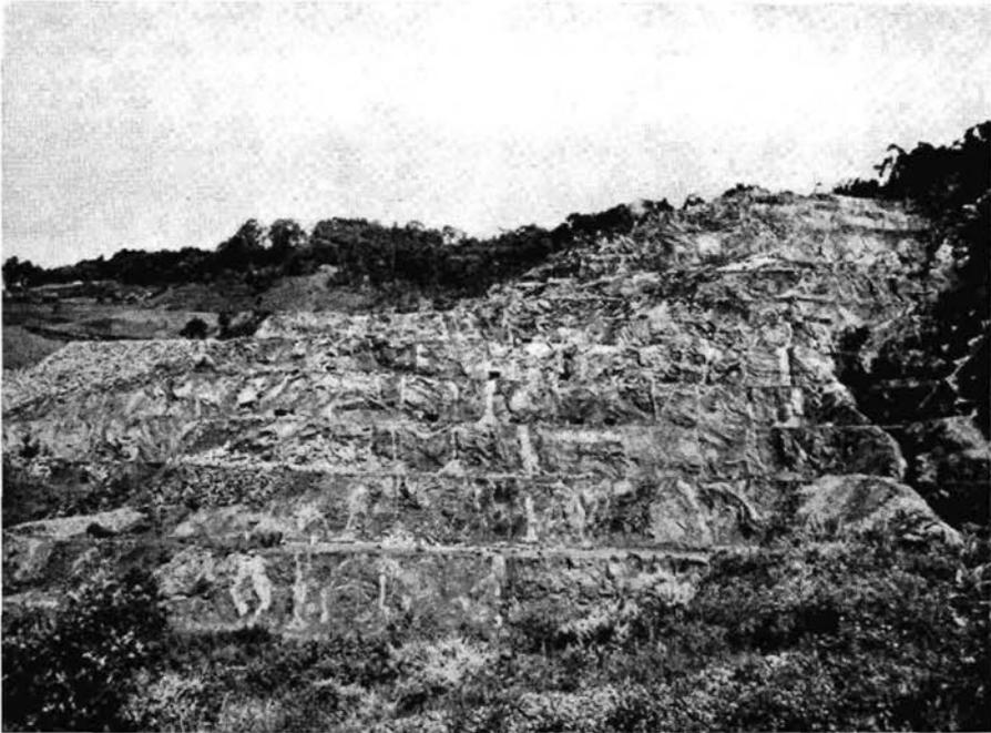
Abb. 6: Ansicht des Abbaubereiches A der Lagerstätte Gifurwe. Die steilstehenden, scharf begrenzten Quarzgänge, die das Nebengestein geradlinig durchschlagen, sind deutlich zu erkennen.
