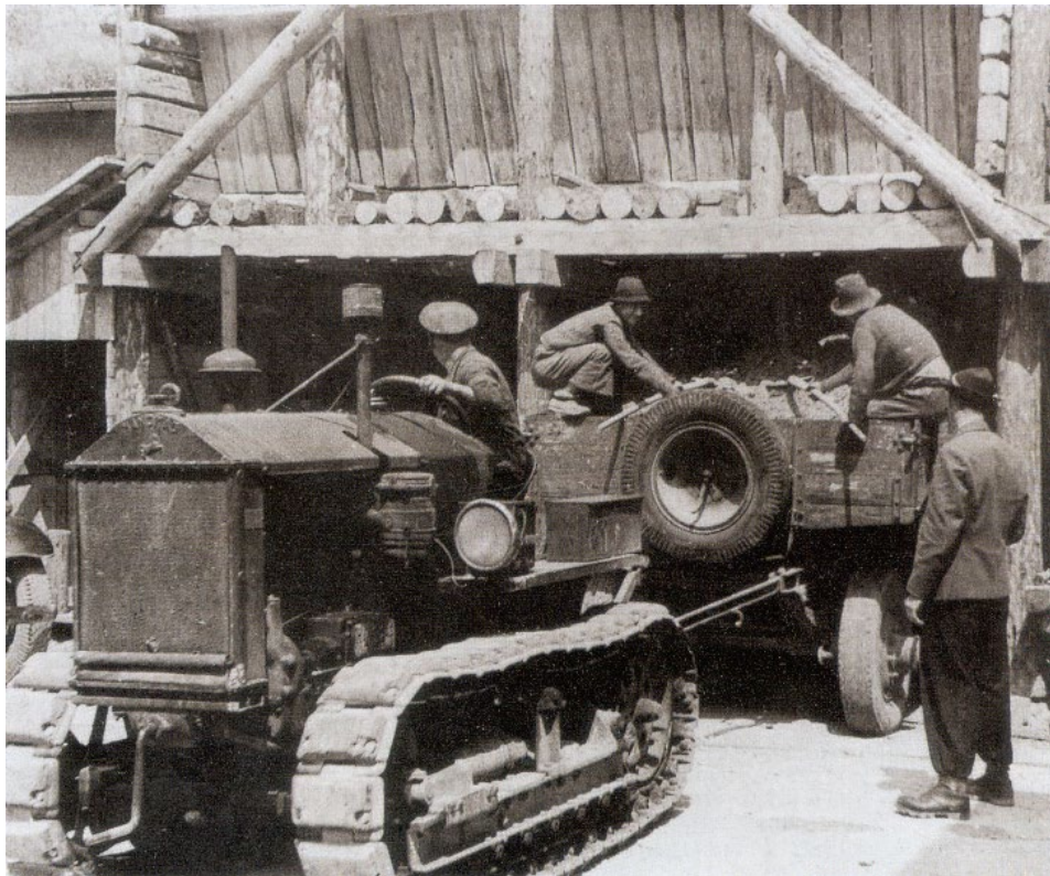
Abbildung 6: Stollenbau in der Mühlauer Klamm, Quelle: ALBRICH (2014).
