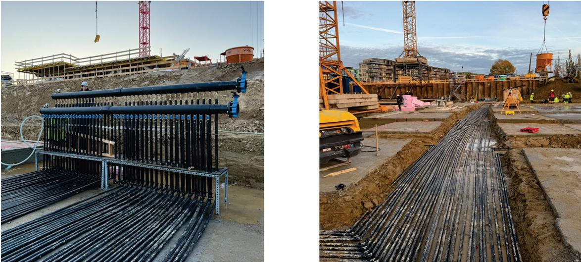
Abbildung 4: Als Bodenplattendurchführung ausgeführten Verteiler (Abb. links) Anbindeleitungen am Beispiel Baufeld 11B - Village im Dritten (Abb. rechts).
