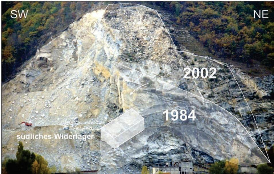
Abbildung 4: Felssturz am 4.10.1984 und beim Ereignis 2002 abgeglittene Felsmassen.
