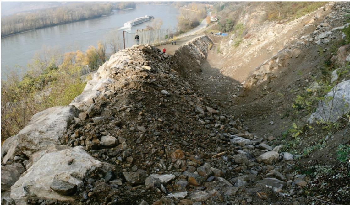
Abbildung 5: Retentionsraum hinter dem Schutzdamm nach erfolgter Ausräumung, Blickrichtung Norden.
