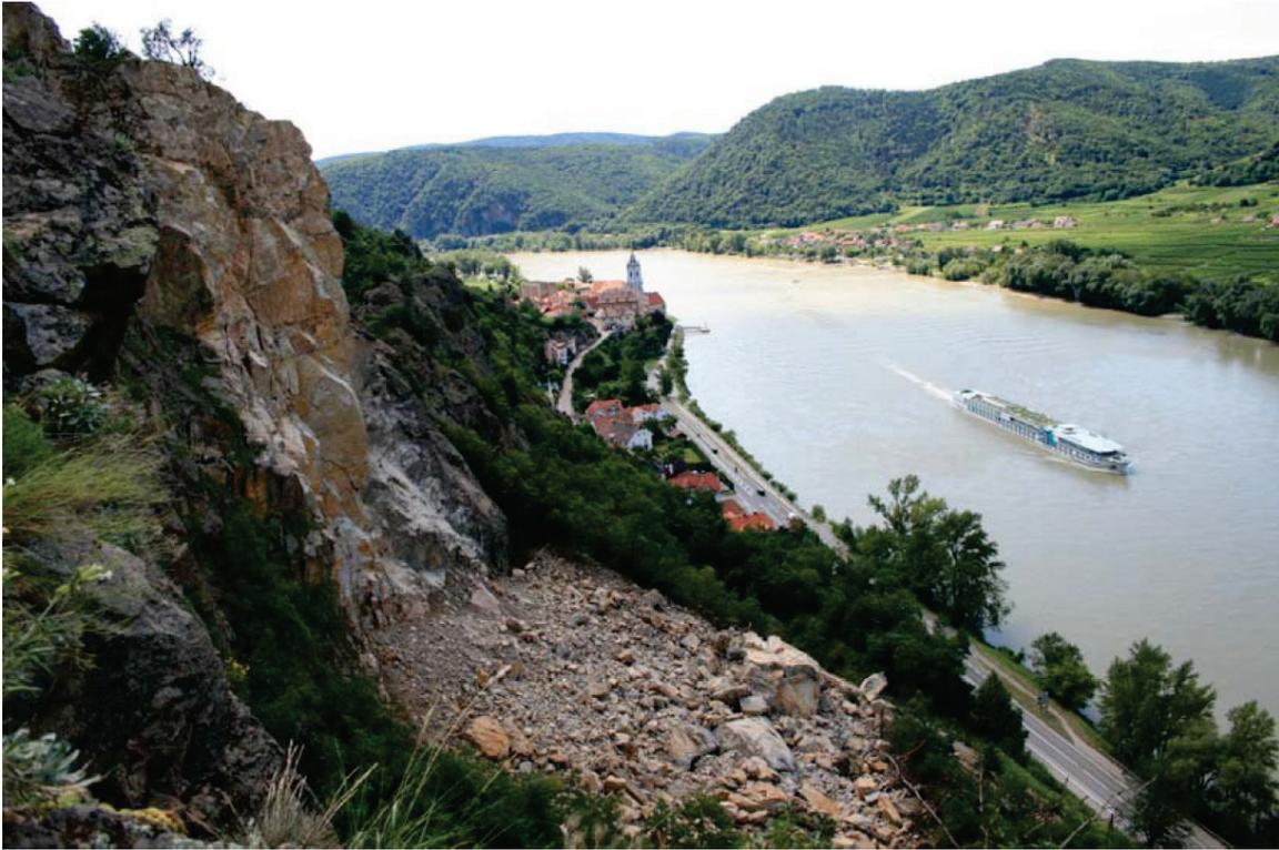
Abbildung 1: Felssturz Dürnstein (Biratalwand), Abbruchvolumen 11.000 – 15.000 m<sup>3</sup>.
