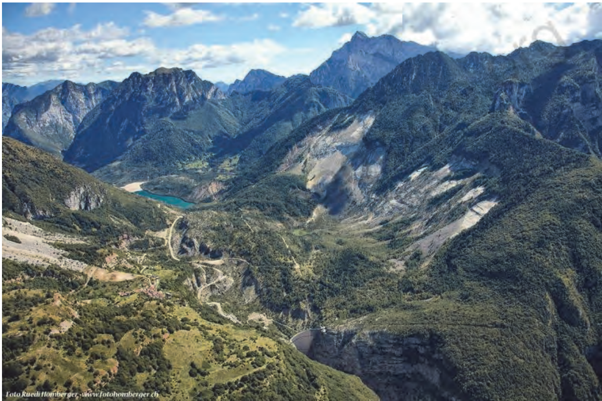
Abb. 5. Massenbewegung Vajont aufgenommen bei einem Flug über dem Piavetal; Blickrichtung Osten (Vajonttal aufwärts); im Vordergrund die Staumauer, Gleitfläche rechts, Restspeichersee im Hintergrund; Piavetal parallel zur Bildebene. (aus: STÜWE & HOMBERGER, 2011)
