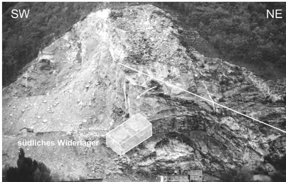
Abb. 8. Ehemaliger Tagbau Spitz an der Donau unmittelbar vor dem Felssturz am 4.10.1984
