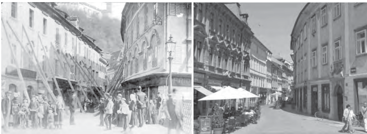
Abb. 2: Schäden nach dem Erdbeben vom April 1895, ©NUK; Foto rechts gibt die heutige Situation wieder.
