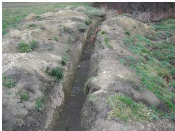
Sanierung des Baches durch Rohrleitung.
