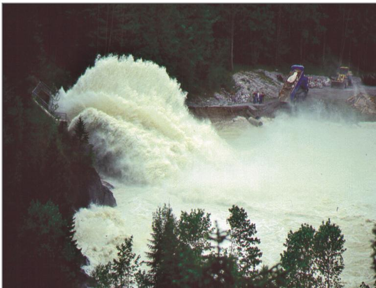
Abb. 4: Hochwasserentlastung 1999 ( $260 \text{ m}^3/\text{s}$ ).
