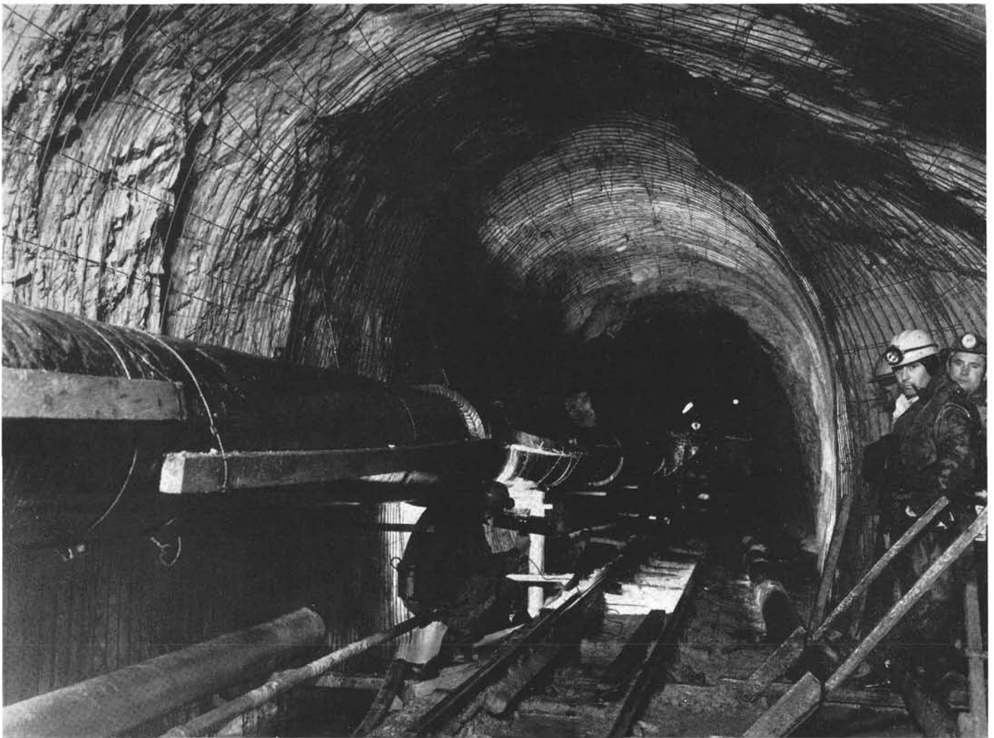
Abb. 44. Armierung mit Baustahlgitter.
