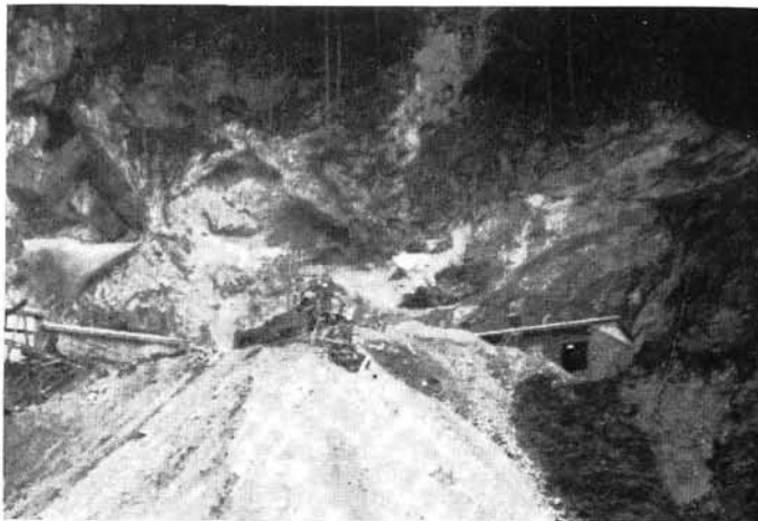
Abb. 5. Anschlagbereich Schneealpenstollen-Nordtrum, bestehend aus wandbildendem Wettersteinkalk und -dolomit.
