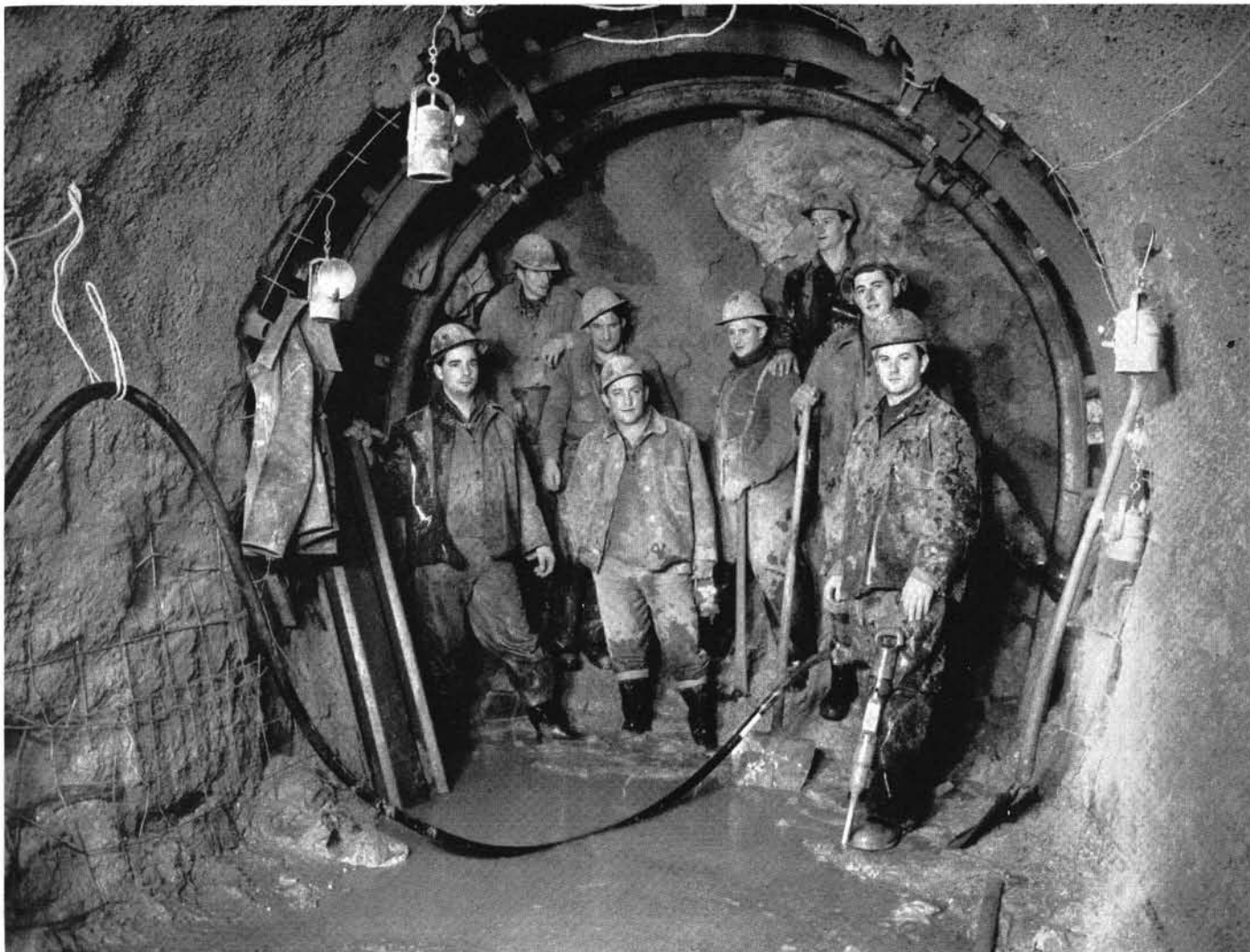
Abb. 46. Armierung mit Profilstahlbögen (Alpinebögen). Links: Baustahlgitter im teilweise fertiggestellten Sicherungsspritzbeton. Trümmerzone im Südtrum.
