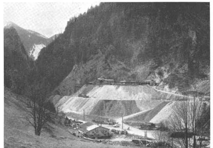
Abb. 48. Stollendeponie Nord. Die Helligkeitsunterschiede lassen die selektive Deponierung des Ausbruchsmaterials zur Vermeidung von Gleitungen im Deponiekörper erkennen.
