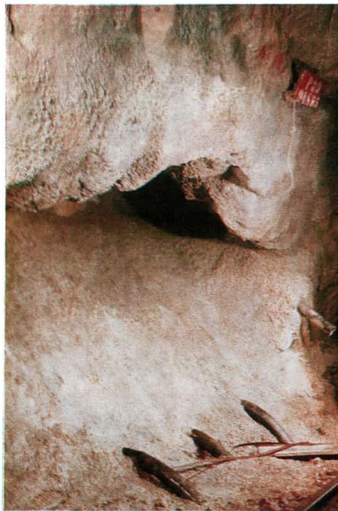
Abb. 9. Mit Spritzbeton plombierte und mit Plastikrohren zur Wasser-ableitung sanierte Sandkluft, Nordtrum, Station 948 bis 952.
