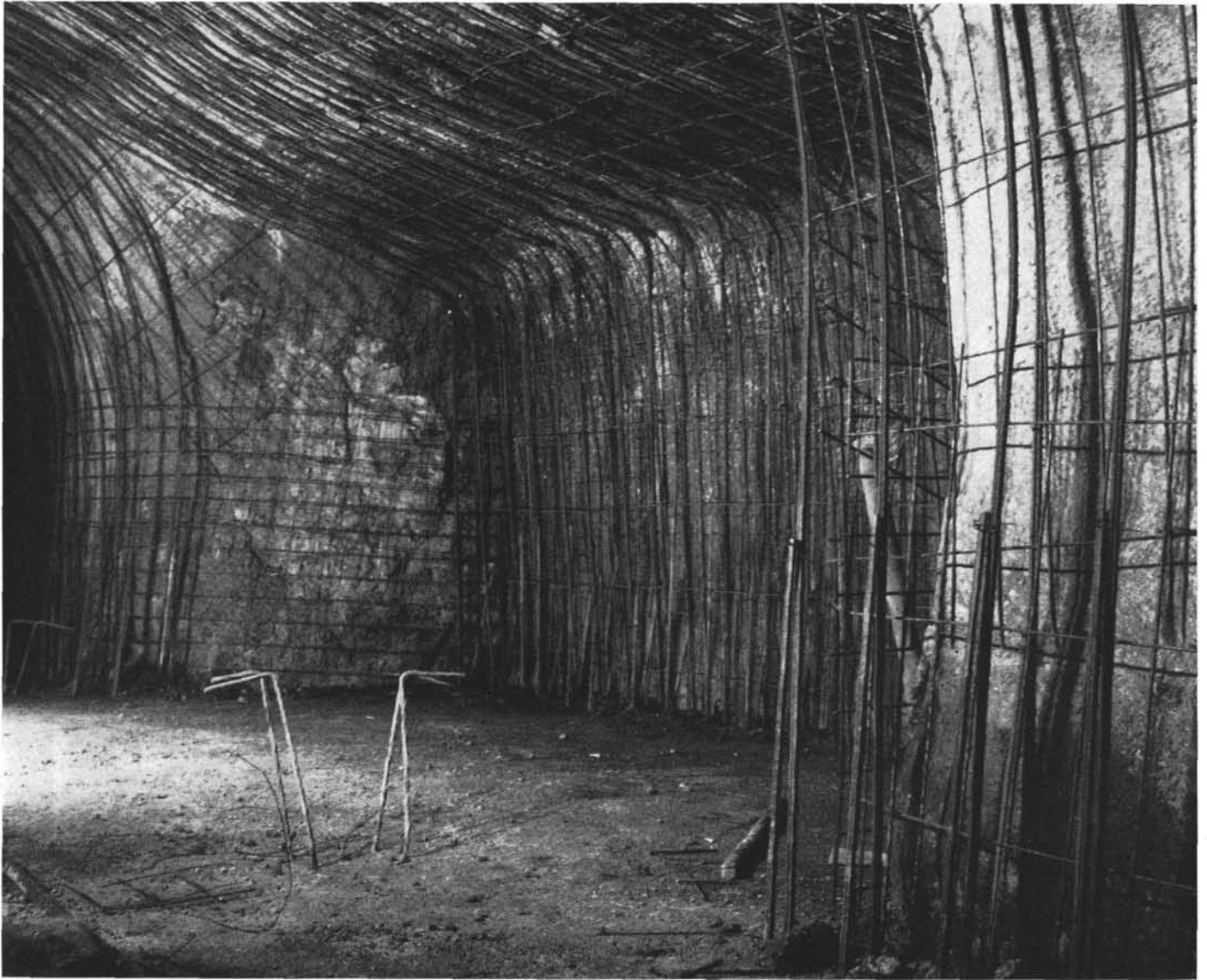
Abb. 45. Thorstahlbögen und -stangen zur Verstärkung der Baustahlgitterarmierung.
