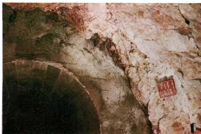
Abb. 8. Beginn der Ringbetonauskleidung, Nordtrum, Station 171 (bis Station 200).
