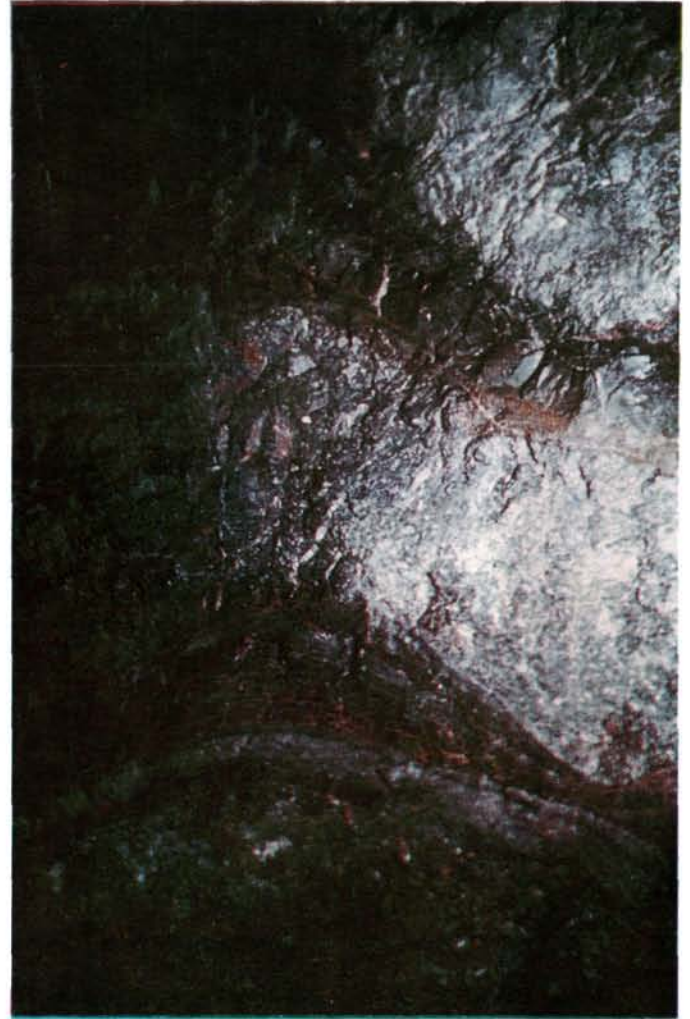
Abb. 14. Intensive Wechsellagerung von Gutensteiner Kalk und Dolomit mit Wettersteinkalk und -dolomit. Nordtrum, Station 3405,5 bis 3589.
