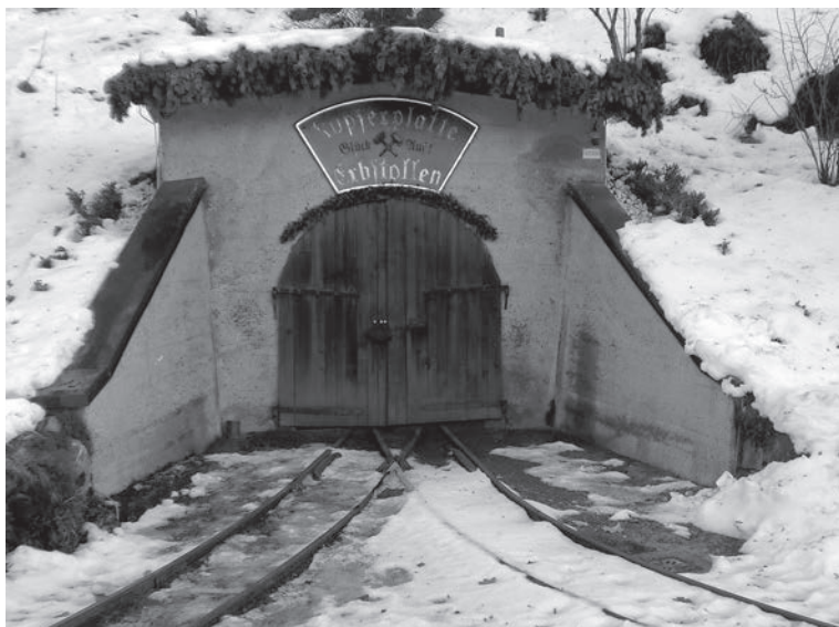
Abb. 38. Das Mundloch des Erbstollens des Schaubergwerkes Kupferplatte in Jochberg (Foto: G. PESTAL).
