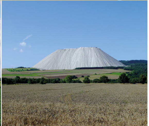
Abb. 24 (entspricht Abb. 2 im Datensatz Halde): Kalisalzhalde „Monte Kali“ bei Dankmarshausen/Heringen (Thüringen/Hessen, DTK 25 Blatt 5025 Hönebach und DTK 25 Blatt 5125 Friedewald; Foto: K. ASCH, 2016)
