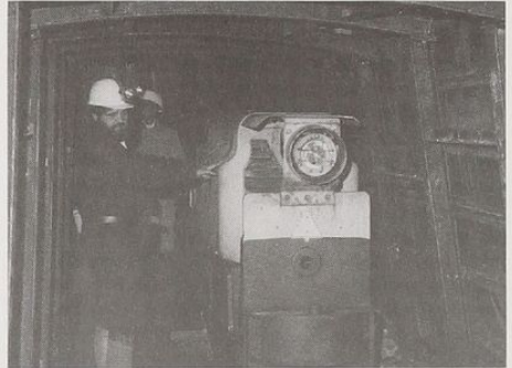
Bild 6: Bergbau Grillenberg, Herlindestollen, Stahlverbau m 0 - 30, Fa. ÖSTU, Fohnsdorf, Tschechische Diesellock.
