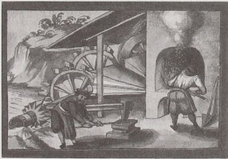
Bild 6: Abbildung aus dem bergbautechnischen Teil des Schwazer Bergbuchs. Leobener Exemplar, Universitätsbibliothek Leoben. Foto Wilke. Der zugehörige Text ist mit "Hammerschmitten" (Hammerschmiede) überschrieben und erläutert die Herstellung und die Ausgabe von Gezähle für die Bergleute.
