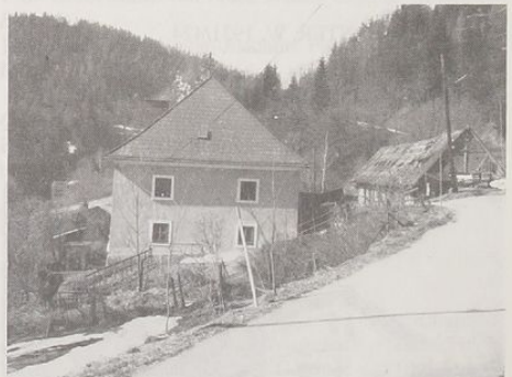
Abb.23: Arbeiterwohnhaus, Neuberg/Mürz, Hammerweg 1.
