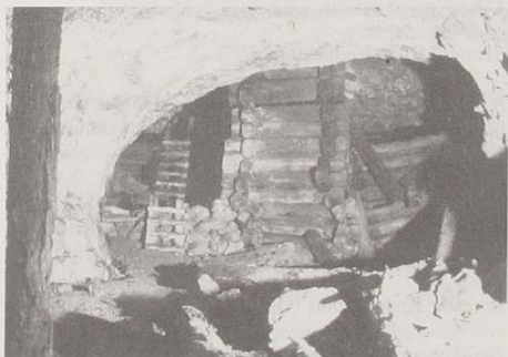
Abb.14: Neuberg an der Mürz, Arztsteinwand, Carl-Borromäus Unterbaustollen, Erzkasten im großen Abbau, Zustand Sommer 1988. (Foto Christian Weiß)
