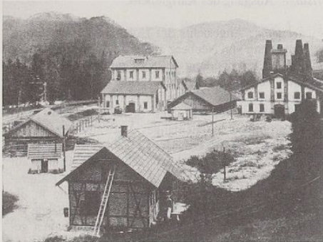
Abb.30: Neuberg an der Mürz, Magnesithütte, Bauzustand um 1920, im rechten Bildteil die vier Schachtöfen.
