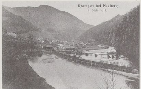
Abb.34: Rechenanlage in Krampen, dahinter das "Hammerfeld". Ansicht um 1910 (Alte Ansichtskarte).
