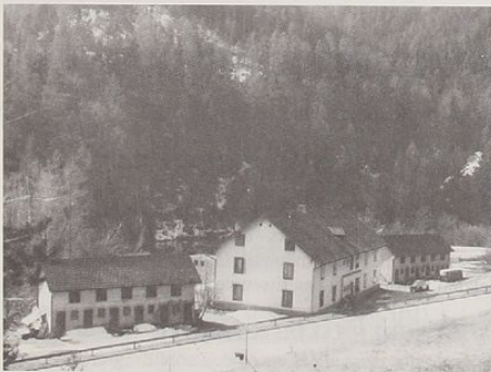
Abb.25: Arbeiterwohnhaus mit Wirtschaftsgebäuden, Neuberg/Mürz, Hammerweg 3. (Foto Alfred Weiß 1992)
