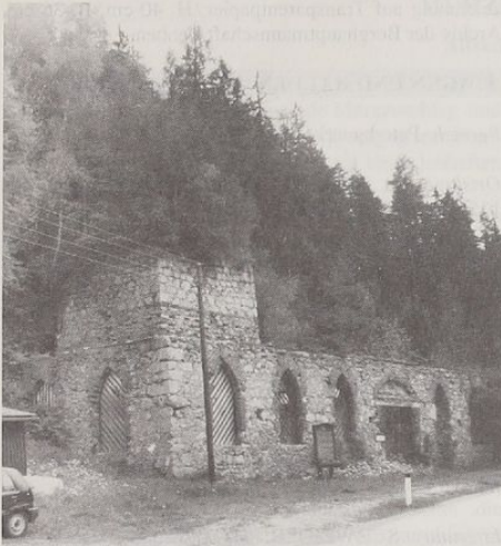
Abb.4: Hochofen in Steinhaus, Bauzustand 1992. (Foto Alfred Weiß 1992)
