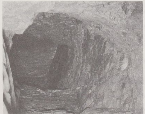
Abb.1: Spital am Semmering, Stollen am Arzberg bei Steinhaus (Blei-Silbererzbergbau), Aufbruch. (Foto Anton Piller)
