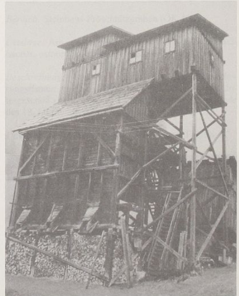
Abb.7: Quarzitbergbau Waldbachgraben bei Kapellen Waldbach 4, Aufbereitungsanlage mit Bunker um 1925 entstanden, Zustand 1991. (Foto Walter Ulm 1991)
