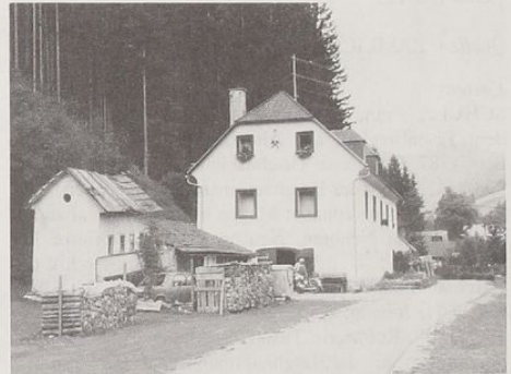
Abb.10: Altenberg an der Rax, Berghaus, Bauzustand 1987. (Foto Otto Fitz 1987)
