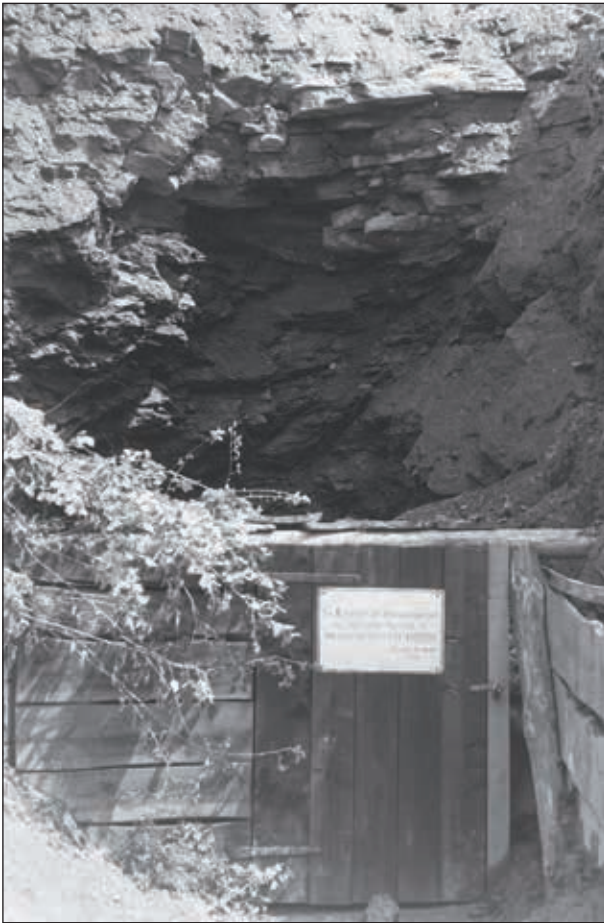
Abb. 27: Mundloch des Max-Fördergesenkes zum Zeitpunkt der Gewaltigungsarbeiten 1975; oberhalb der Zimmerung ist der gebankte Kalkstein der „Kalkrippe“ aufgeschlossen, die zumindest in der Haufenreither Lagerstätte als markanter Leit-horizont fungiert (Foto WEBER).
