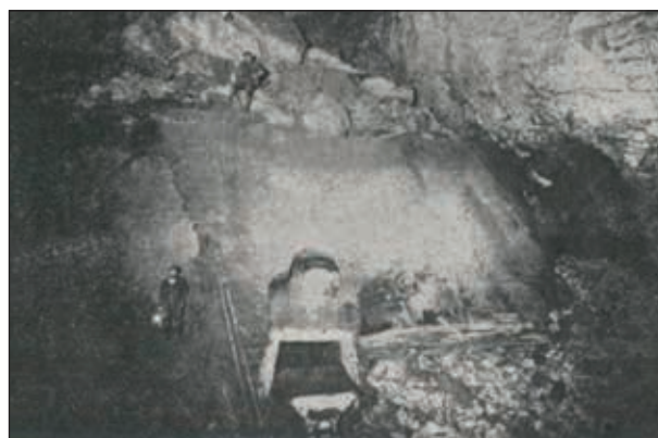
Abb. 48: Drachenhöhle, Förderstollen durch den 1. Verbruch (aus 108 )
