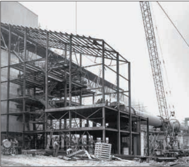
Abb. 46: Bau der Drehrohrofenanlage (1972); (Bildquelle: RHI Magnesita)
