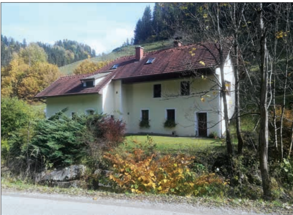
Abb. 18: Bachsimmerlgebäude (Bauzustand 2019; Foto WEBER)
