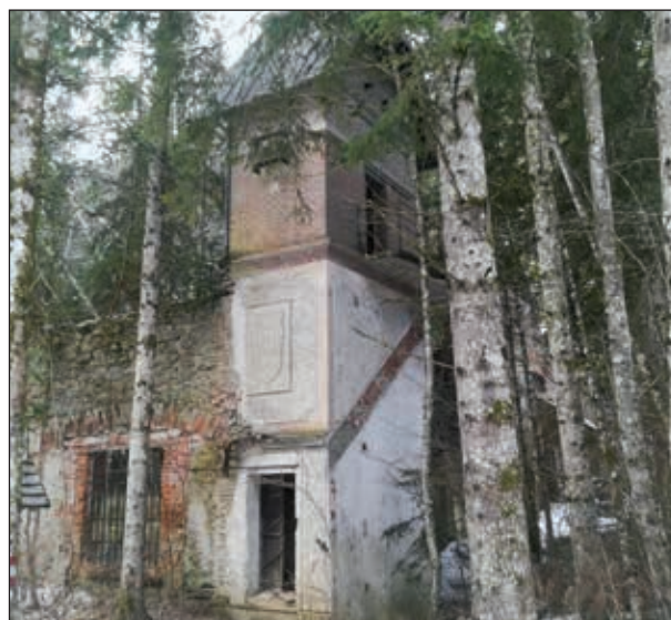
Abb. 26: Ruine der Haufenreither Aufbereitung (Stand 2022; Foto WEBER)
