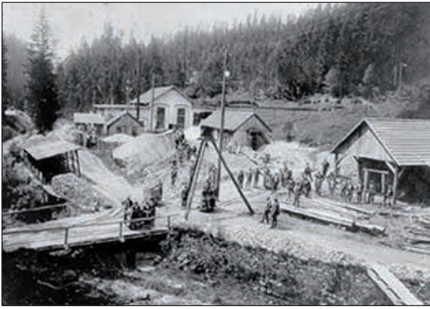
Abb. 22: Die Fotografie zeigt die bereits elektrifizierte Aufbereitungsanlage (Archiv Knappenverein Arzberg)
