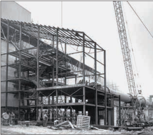
Abb. 46: Bau der Drehrohrofenanlage (1972); (Bildquelle: RHI Magnesita)
