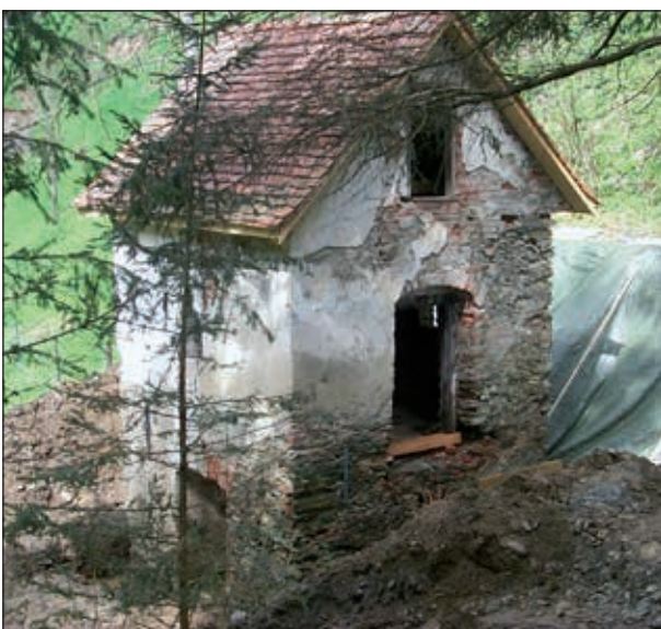
Abb. 4: Pulverturm vor der Restaurierung
