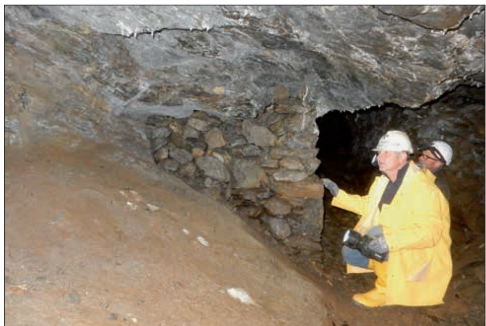
Abb. 14: Unterer Raabstollen, im Erzlager verlaufender Weitungsbaue (Foto WEBER, 2020)
