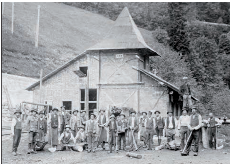
Abb. 33: Belegschaft des Kiesbergbaus Naintsch bei der Errichtung der Werksanlagen (Jahr ?); (Archiv: Imerys)
