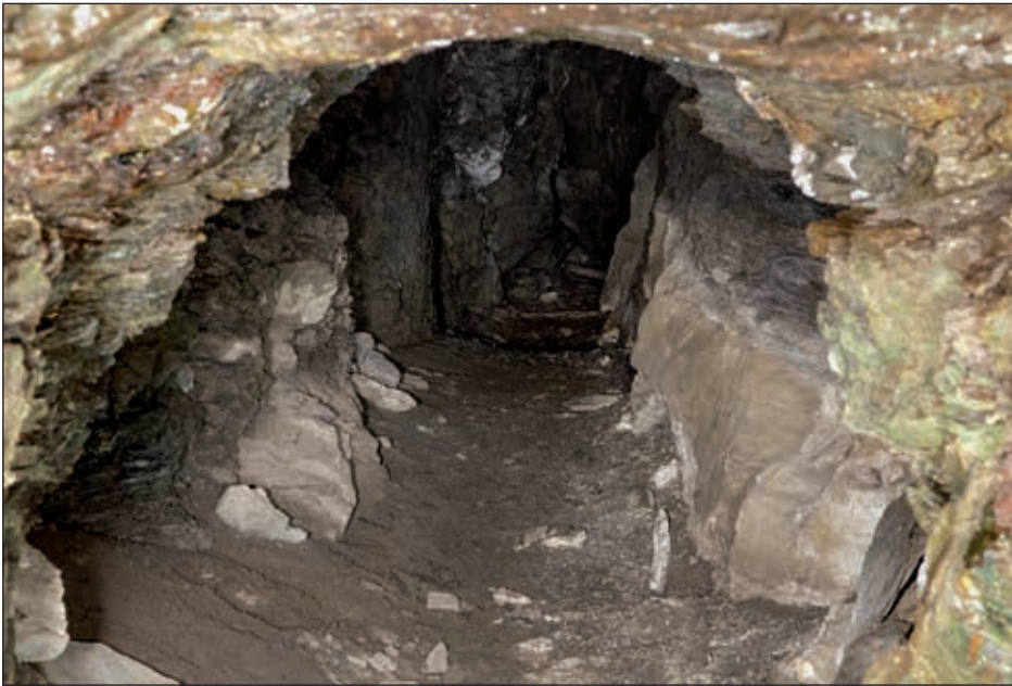
Abb 7: Einer der wenigen noch zugänglichen handgeschrämmten Stollen am Straßegg, Februar 2022. Foto. H.-P. Bojar.
