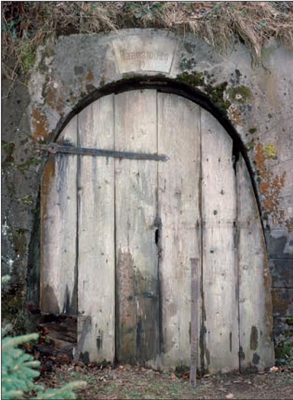
Abb. 8: Mundloch des 1911 angeschlagenen Neuen Raabstollens (Stand 1990, Foto WEBER)
