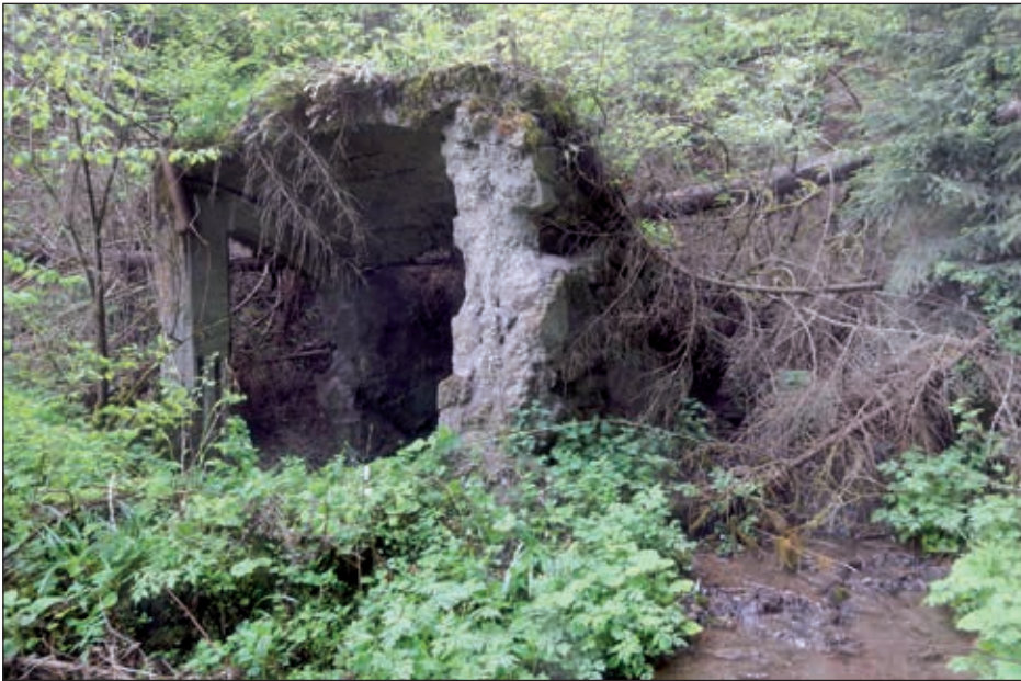
Abb. 34: Portal des Sedlaczek Gesenkes (Stand 2020) unmittelbar neben dem Pointnerbach (rechts); (Foto WEBER)
