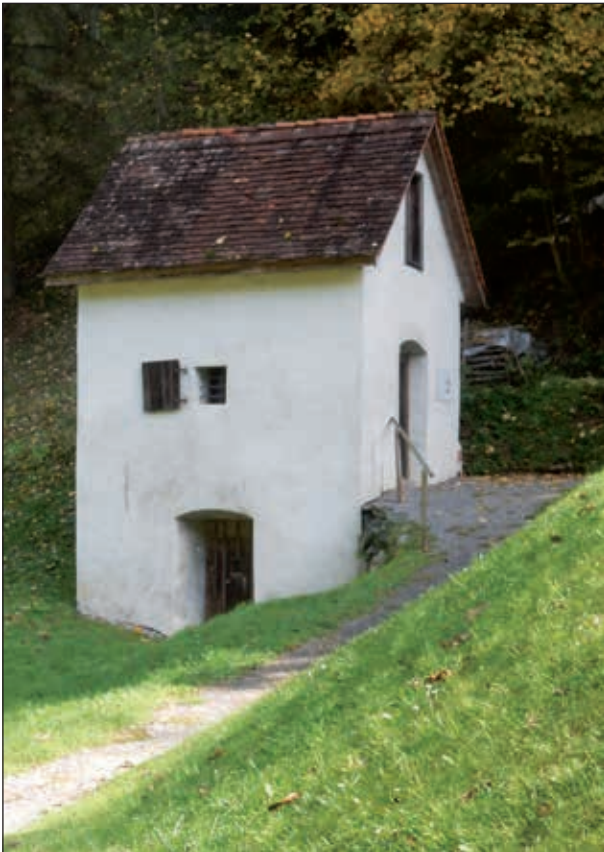
Abb. 13: Restaurierter Pulverturm von Arzberg (2020) (Foto WEBER)
