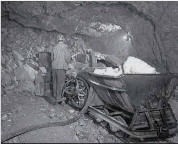
Abb. 42: Gleisgebundener Wurfschaufellader (Bildquelle: RHI Magnesita)
