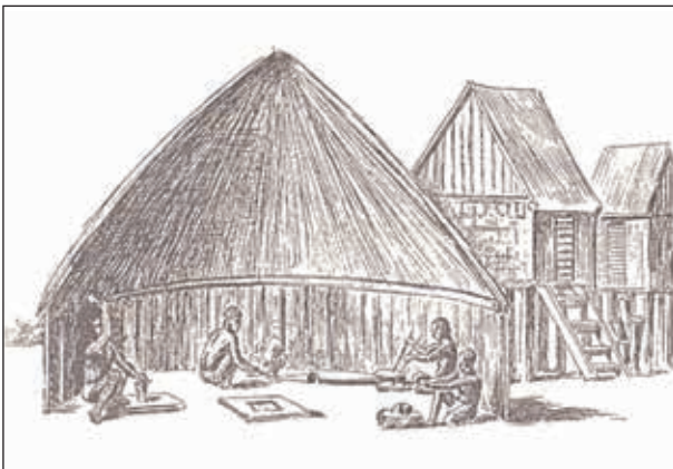
Abb. 3: Schmiede zur Eisenverarbeitung bei den Baluba
