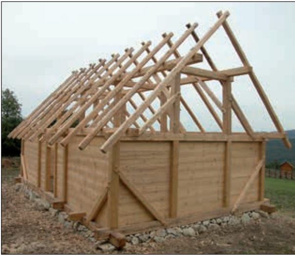
Abb. 4: Rohbau eines Wohngebäudes im keltischen Freilichtmuseum am Burgberg in Schwarzenbach in der Buckligen Welt mit Schwellbalkenkranz, Wandständern, Riegelwänden, Pfettenhölzern und Rofenbäumen; manche Gebäude waren bereits in der Eisenzeit innen in mehrere Räume unterteilt (Foto: W. F. A. Lobisser)
