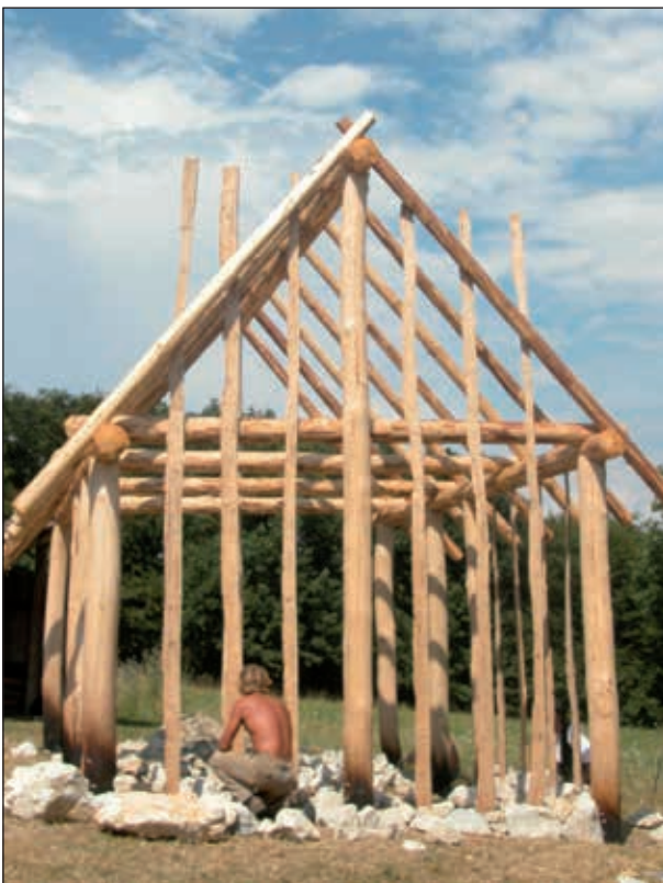
Abb. 5: Das Architekturmodell eines Wirtschaftsgebäudes in Pfostenbautechnik mit eingetieften Pfosten, Pfetten, Binderbalken und Rofen während der Bauarbeiten; An der Frontseite finden sich bereits stehend kleine Spalthölzer befestigt, um welche anschließend Wände aus Haselruten geflochten wurden (Foto: W. F. A. Lobisser)
