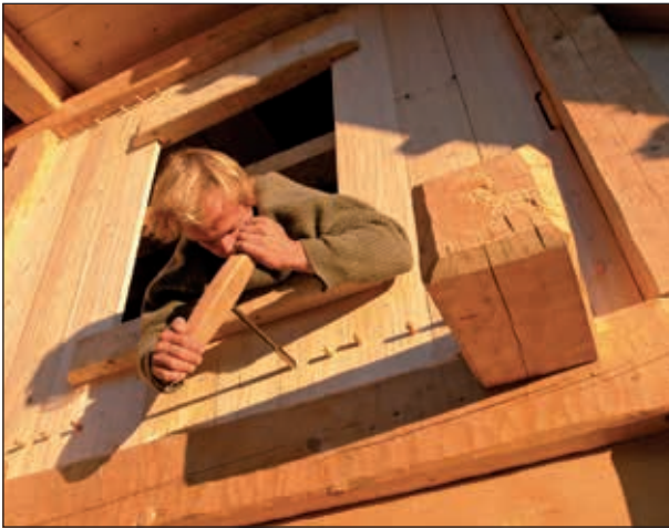
Abb. 10: Wir dürfen davon ausgehen, dass man in der jüngeren Eisenzeit viele Konstruktionselemente durch Holznagelverbindungen gesichert hat; die Löcher für die Holznägel wurden mit Löffelbohrern vorgebohrt (Foto: W. F. A. Lobisser)
