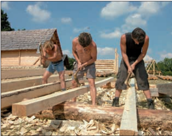
Abb. 9: Arbeitsspuren an erhaltenen Bauhölzern der eisenzeitlichen Gewerbebesiedlung am Dürrnberg bei Hallein zeigten eindeutig, dass die flächige Überarbeitung von Bauhölzern in der Eisenzeit mit Dechseln erfolgte; deshalb haben wir auch die Bauhölzer für das Freilichtmuseum in Schwarzenbach mit Dechseln (auch Querbeile genannt) zugearbeitet (Foto: W. F. A. Lobisser)
