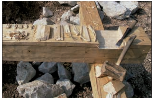
Abb. 8: An einem Schwellbalken wurde die rechteckige Ausnehmung einer Überblattung mit einem Tüllenmeißel ausgearbeitet; In Schwarzenbach wurden auch die dabei erzeugten Holzabfälle dokumentiert, um sie mit Originalabfällen vom Ramsautal am Dürrnberg vergleichen zu können (Foto: W. F. A. Lobisser)
