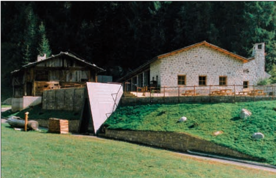
Abb. 5: Anfahrtsgebäude beim St. Ignaz-Erbstollen in Prettau.
