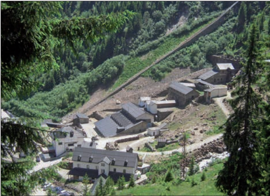
Abb. 3: Gesamtansicht des Standortes Maiern mit zentralem Teil der Erzaufbereitung, Verwaltungs- und Museumsgebäuden sowie hinten den Maierner Bremsberg. Foto: Marcus Wandinger, 27. Juni 2010
