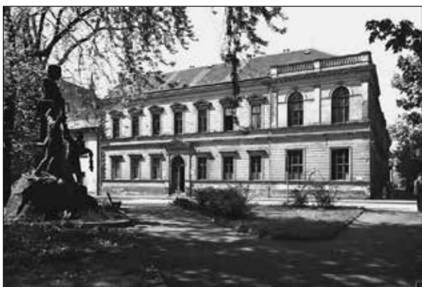
Abb. 2: Peter Tunner-Gebäude um 1890 (Universitätsarchiv, Bildokumentation)
