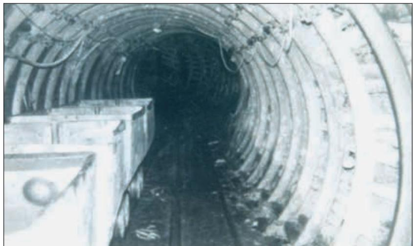
**Abb. 13: In der Anlage VI, Eisenringausbau**
