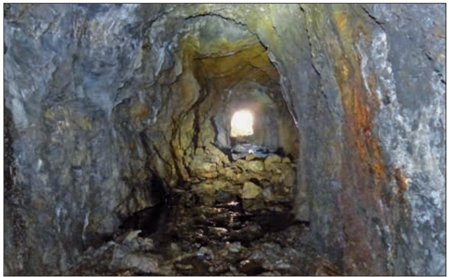
Abb. 16: Stollen im Bereich Johanni Hauptbau – Foto Johannes Zeilinger, Dezember 2015
