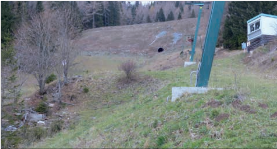
Abb. 13: Bergstation WSV-Muldenlift – Foto Johannes Zeilinger, November 2015
