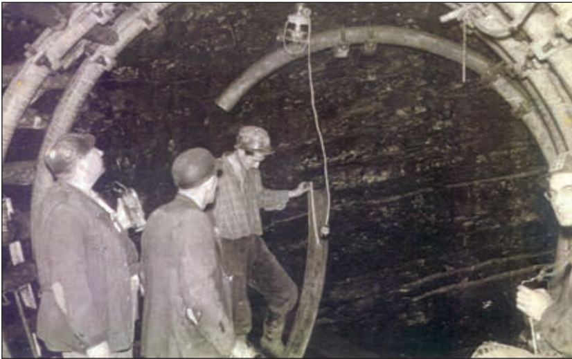
Abb. 12: Vortrieb mit Eisenringausbau in der Anlage VI. Von links: Obersteiger Karl Kanitsch, Steiger Dörre, Dörre junior, Maschinensteiger Nikolaus Sifferlinger
