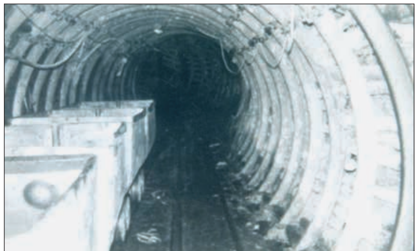
Abb. 13: In der Anlage VI, Eisenringausbau
