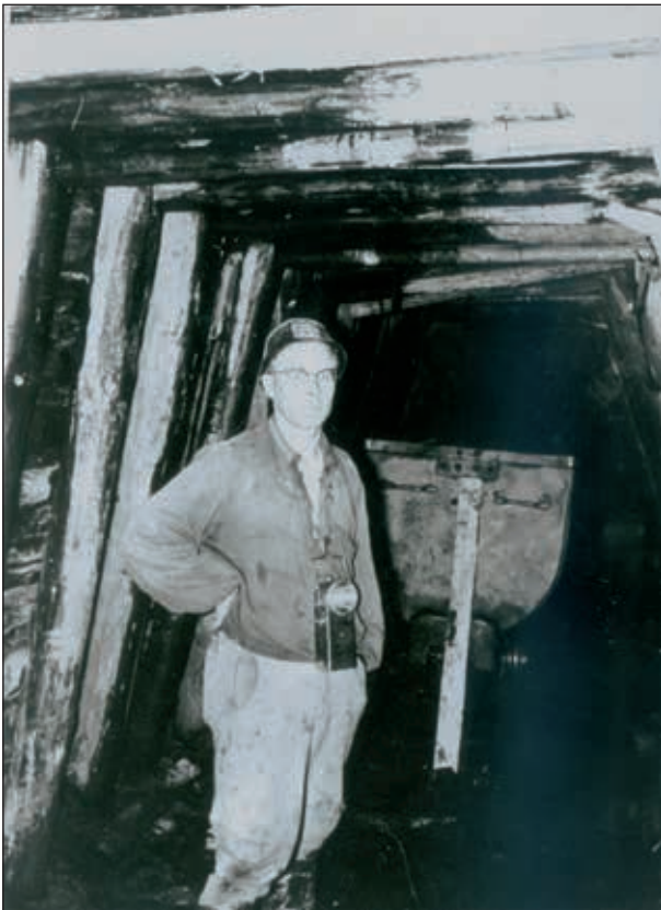
Abb. 6: Maschinensteiger Nikolaus Sifferlinger untertage in Wiesenau, Holzzimmerung, das Geleucht ist ein elektrischer Akkublitzer, der für jeweils 10 Sekunden Licht gab
