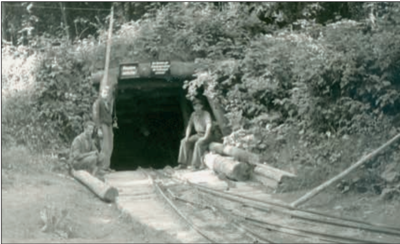
Abb. 8: Stollenmundloch der Anlage V in Wiesenau
