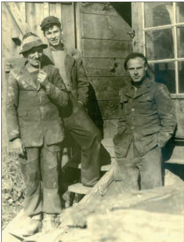
Abb. 7: Vor dem Haspel der Anlage III in Wiesenau im Jahre 1951. Rechts Maschinensteiger Nikolaus Sifferlinger
