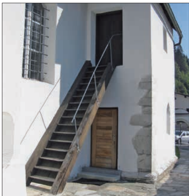
Abb. 11: Aufgang zum Oratorium der Gewerke Tunner an der Pfarrkirche von Salla. (Foto: Ing. Peter Weißnar, 2018.)
