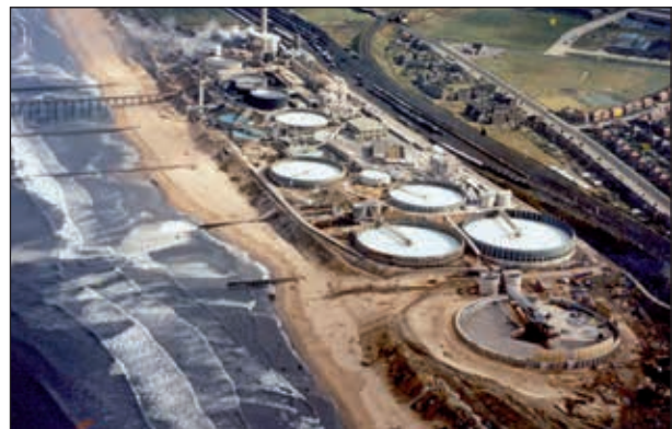
Abb. 8: Gewinnung von Magnesia aus Meerwasser, Mg 2+ -Gehalt: 1,3 % Fällungs- und Absetzbecken; Fällung des Magnesiums gemäß: MgCl_2 + Ca(OH)_2 \rightarrow Mg(OH)_2 + CaCl_2 . Für 1t Magnesiumoxid werden 400 m 3 Meerwasser, 22 m 3 Süßwasser und 2,7 t Dolomit benötigt.
