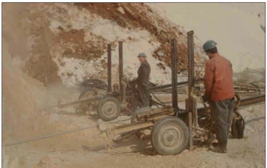
**Abb. 19: Pressluftbetriebene Bohrlafetten (BVB), Herstellen von Sohlöchern**
