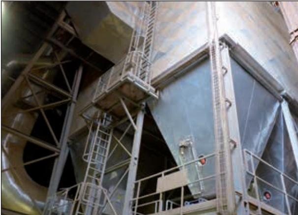
**Abb. 39: Schlauchfilter für Ofenabgasentstaubung, 2012. 1350 Schläuche, 4.200 m<sup>2</sup> Filterfläche**
