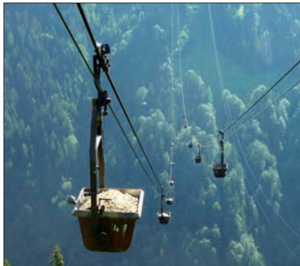
**Abb. 32:** Seilbahn 2, 1000 m Spannweite, 270 m über Grund
