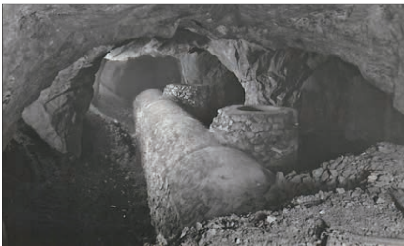
Abb. 10: Hochabbau Horizont X im Jahre 1958, Abbau-Grundsohle mit den betonierten Abzugsstrecken vor dem Einbringen der ersten Versatzscheibe. Seitlich rechts sind zwei gemauerte Magnesitrollen zu sehen, die dem Abbau folgend, im Versatz scheibenweise verlängert wurden.
