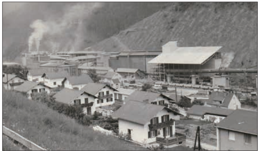
Abb. 11: Drehofen 3. Das Werk Breitenau am 24.6.1973, der Langdrehrohrofen DO3 befindet sich in der Endmontage. Das Kühlrohr und der Ofenkopf sind ohne die Verkleidung des Flugdaches noch gut erkennbar. Dahinter befinden sich die neuen Rohsteinbunker.
