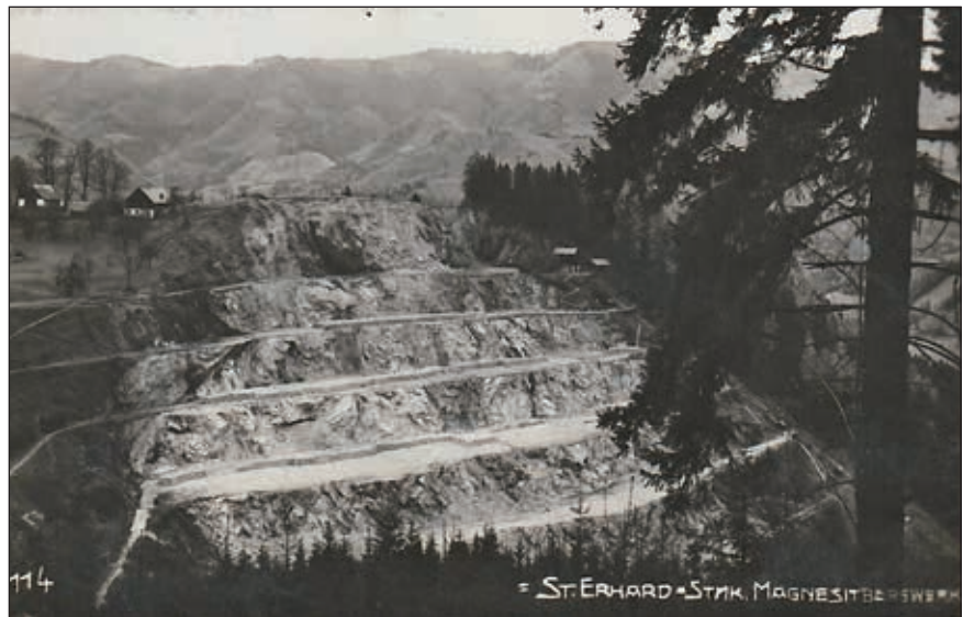
Abb. 6: Der Breitenauer Tagbau im Jahre 1926, dem Jahr des ersten Betriebsstillstandes. Am linken Bildrand das Gehöft Grossreiter, auf den Etagen sind die sogenannten „Figuren“ aus sortiertem Magnetit für die Gedingeberechnung erkennbar.
