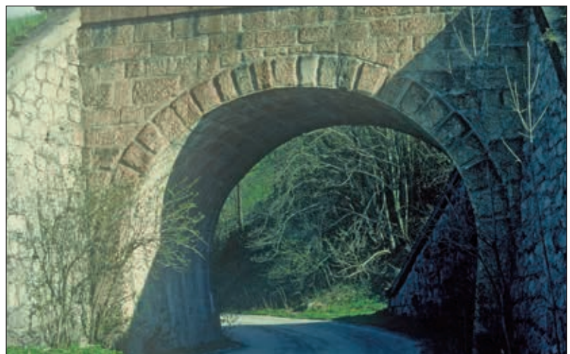
Abb. 1: Unterführung Gaishorn. Eine bereits historische Ansicht der Straßenunterführung der alten Trasse der Kronprinz Rudolf-Bahn bei Gaishorn. Der Gewölbeteil des Durchlasses wurde im Jahre 1872 aus behauenen Magnesitquadern der Lagerstätte Wald errichtet.
