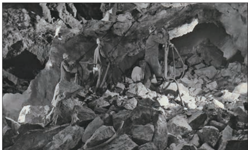
Abb. 9: Bohrarbeiten im Schrägbau. Schrägbau am Horizont X im Jahre 1958, händische Bohrarbeit am Hauwerk stehend. Die Versatzböschung und die (beleuchtete) Versatzstrecke sind im rechten Bildteil oben zu erkennen.
