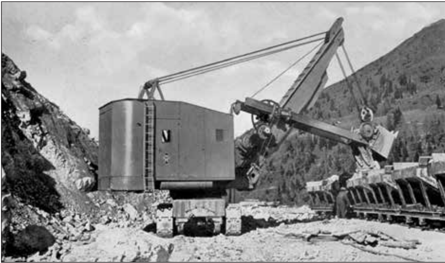
Abb. 11: Elektrischer Seillöffelbagger bei der Abraumverladung
