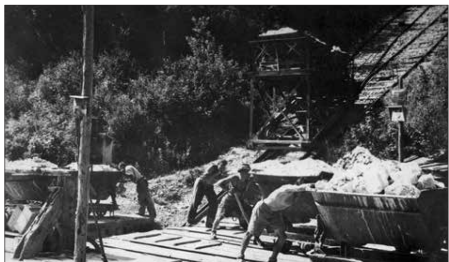
Abb. 5: Rangieren der Förderwagen
