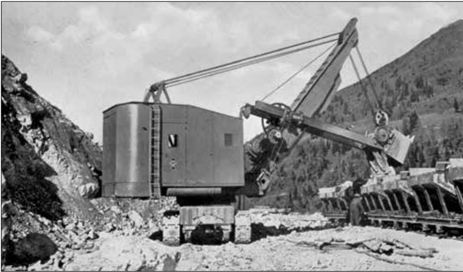
**Abb. 11: Elektrischer Seillöffelbagger bei der Abraumverladung**
