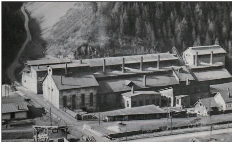
*Abb. 7: Die Breitenauer Werksanlagen im Jahre 1952. Der Horizont X mit dem „Augustinstollen“ ist noch nicht angeschlagen. Im rechten Bildteil ist der 1949 errichtete Sinterbunker mit Sinteraufzug zu erkennen.*
