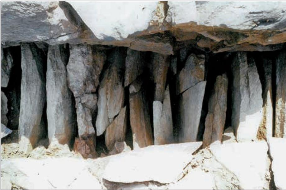
**Abb. 5: Aschenrost der Arsenverhüttungsanlage in der „Woaznbichler Halt“, Foto: G. Christian (2007)**
