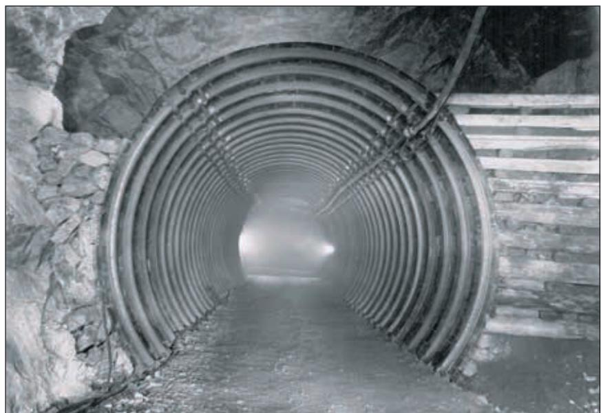
**Abb. 12: Ringzimmerung Revier IV. Überbauen der Schrägstrecke Revier IV – V im Jahre 1977. Der Einbau einer Stahlringzimmerung im Versatz des Revieres IV West erhält den Zugang zur Ausrichtungsstrecke für die tieferen Lagerstättenteile.**
