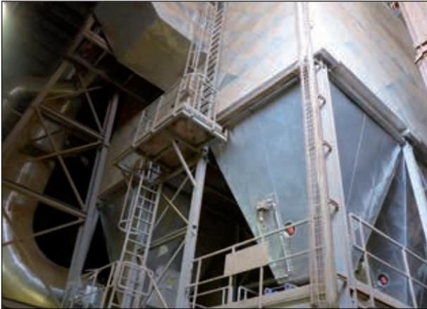
**Abb. 39: Schlauchfilter für Ofenabgasentstaubung, 2012. 1350 Schläuche, 4.200 m<sup>2</sup> Filterfläche**
