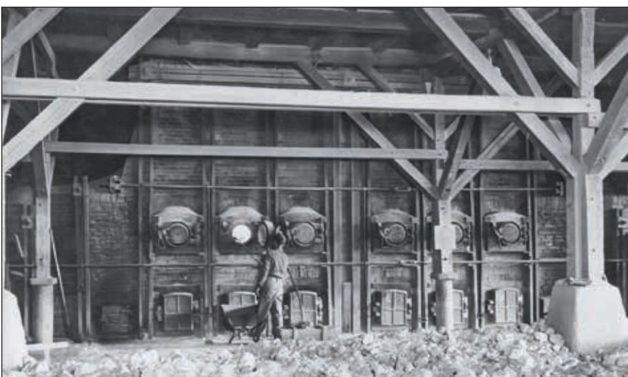
*Abb. 5: Schachtöfen – Neubau in Oberdorf um 1920*
