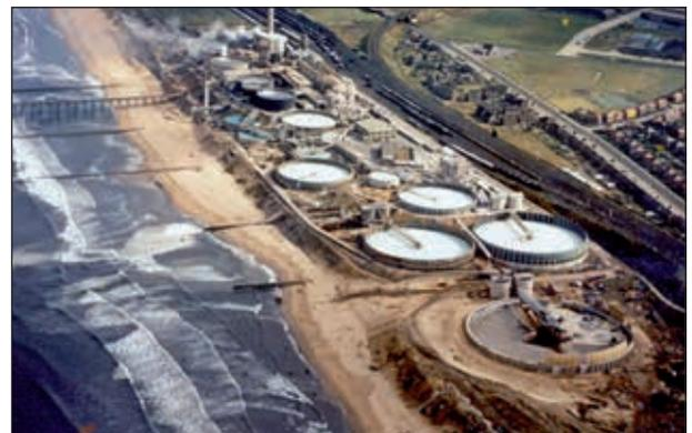
**Abb. 8: Gewinnung von Magnesia aus Meerwasser, Mg<sup>2+</sup>-Gehalt: 1,3 % Fällungs- und Absetzbecken; Fällung des Magnesiums gemäß:  $MgCl_2 + Ca(OH)_2 \rightarrow Mg(OH)_2 + CaCl_2$ . Für 1t Magnesiumoxid werden 400 m<sup>3</sup> Meerwasser, 22 m<sup>3</sup> Süßwasser und 2,7 t Dolomit benötigt.**
