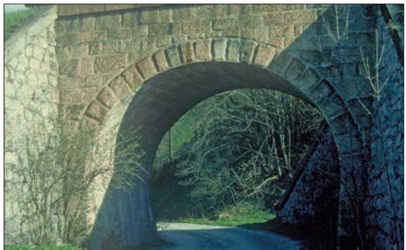
Abb. 1: Unterführung Gaishorn. Eine bereits historische Ansicht der Straßenunterführung der alten Trasse der Kronprinz Rudolf-Bahn bei Gaishorn. Der Gewölbeteil des Durchlasses wurde im Jahre 1872 aus behauenen Magnesitquadern der Lagerstätte Wald errichtet.
