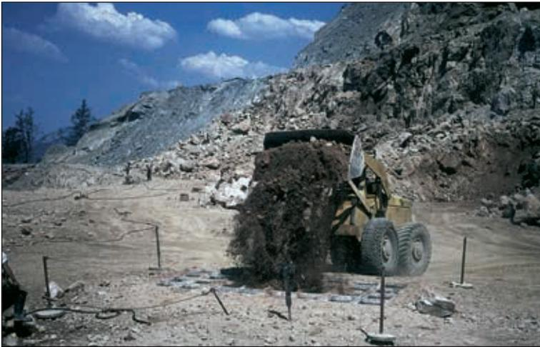
Abb. 20: Materialabwurf in den Sturzschacht. Man beachte die Kinematik des Michigan Radladers.
