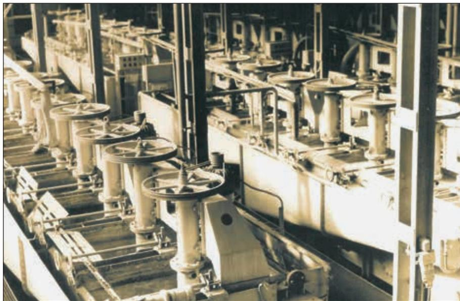
**Abb. 10: Flotationszellen**
