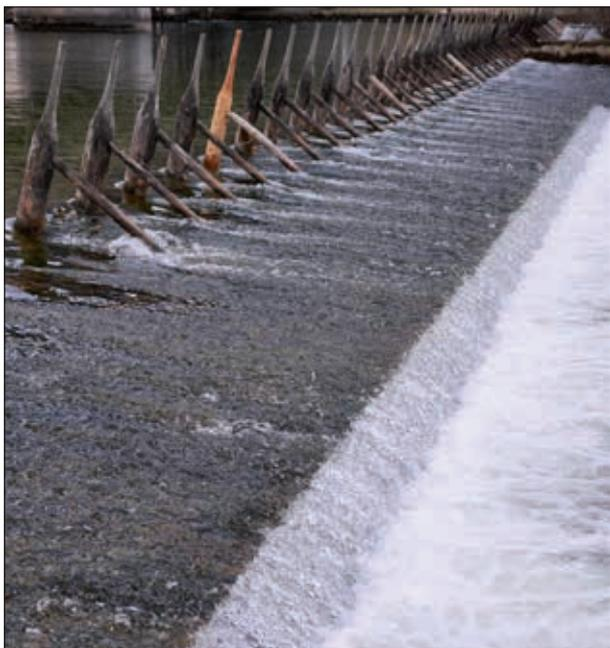
**Abb. 4: Der Polster mit den abgestützten Docken**
