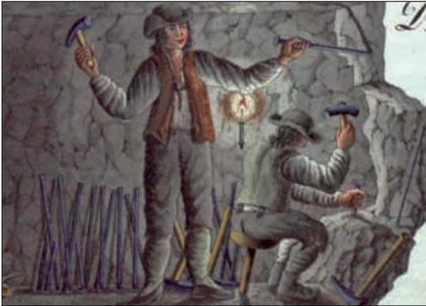
**Abb. 3: Bohren der Schusslöcher zum Sprengen mit Pulver im Kalkgestein**
