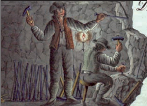
Abb. 3: Bohren der Schusslöcher zum Sprengen mit Pulver im Kalkgestein OÖLA, Salzoberamtsarchiv Gmunden, Hs 31, Tab. XIII, fol. 16
