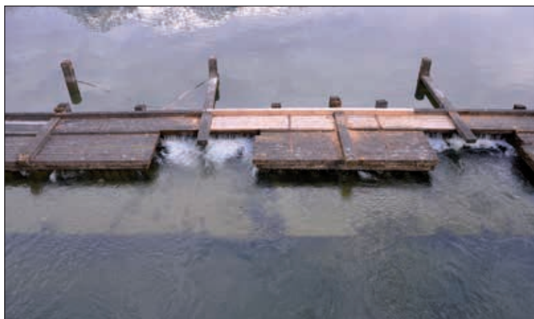
Abb. 6: Klausstuben und Tore der Seeklause in Steeg am Hallstätter See (© TICCIH; Foto: G. Dinhobl)
