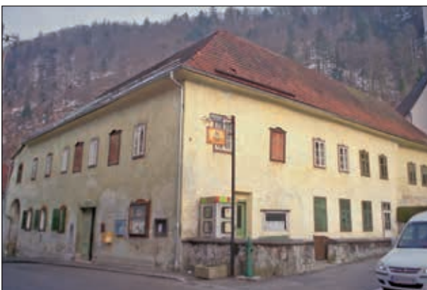
Abb. 8: Das Salzfertigerhaus Lauffen 15: Ansicht vom Kirchenplatz aus, ganz links anschließend das Haus Lauffen 21, ursprünglich ebenfalls ein Salzfertigerhaus, eine Zeitlang auch als „Rathaus“ dienend. Foto: Federspiel
