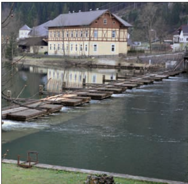
Abb. 2: Übersicht über die Seeklause (Niederwasser) mit den ‚Klausstuben‘ (© TICCIH; Foto: G. Dinhobl)
