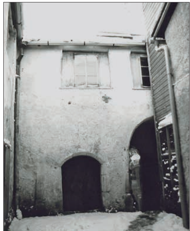
Abb. 9: Blick in den Innenhof: ein Bogen des Arkadengangs ist noch offen, links zwischen Türe und Hofecke ist ein zweiter, eingemauerter Bogenpfeiler sichtbar. Foto: Federspiel
