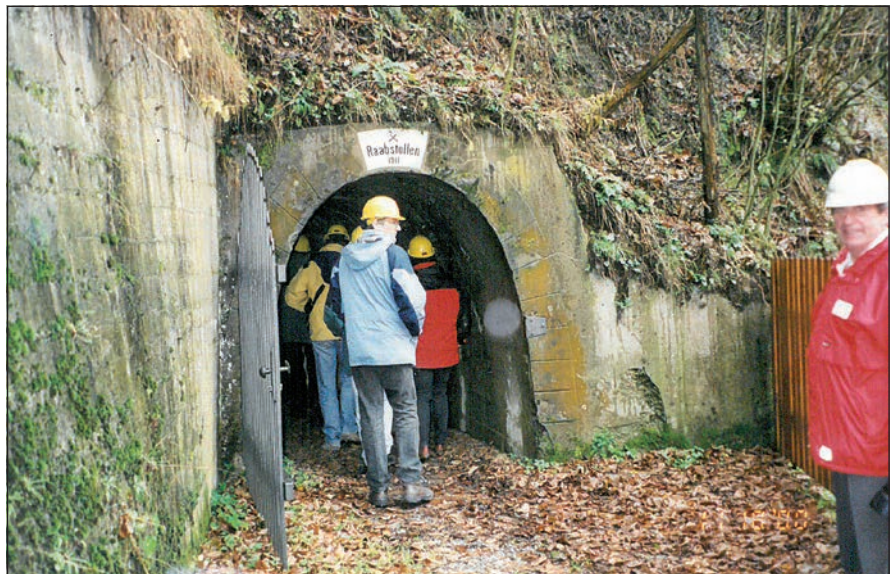
Abb. 2: Mundloch des Raabstollens in Arzberg. Aufnahme: H. J. Köstler, November 2000
