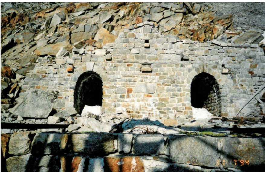
Abb. 15: Stollenmundlöcher für die Umlaufseilbahn beim Molybdänglanz-Bergbau an der Alpeiner Scharte (Materialeilbahn vom Bergbauegebiet zur Hohen Kirche und weiter zur Aufbereitung im Valsler Tal).
