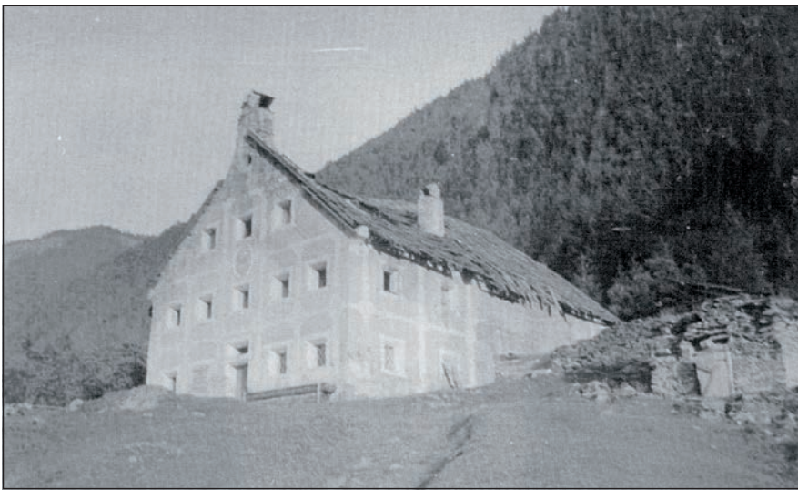
Abb. 10: Verweserhaus in Schellgaden (Lungau) beim Gold- und Silberbergbau; von diesem einst ansprechenden Gebäude sind nur noch die Grundmauern vorhanden.
