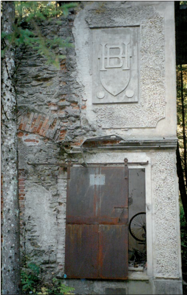
Abb. 3: Gebäude der Aufbereitung in Haufenreith; HB = Haufenreither Bergbau. Aufnahme: H. J. Köstler, Oktober 2001
