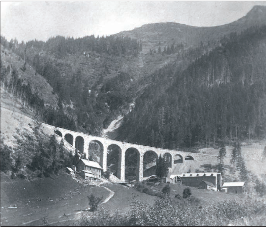
Abb. 7: Weiritzgraben-Viadukt im Abschnitt Eisenerz-Präbichl der Zahnradbahn Eisenerz-Vordernberg; 1891 Inbetriebnahme dieser weithin beachteten Bahn. Undatierte Aufnahme (wahrscheinlich bald nach 1891), Sammlung H. J. Köstler (Nachlass Wilhelm Schuster).
