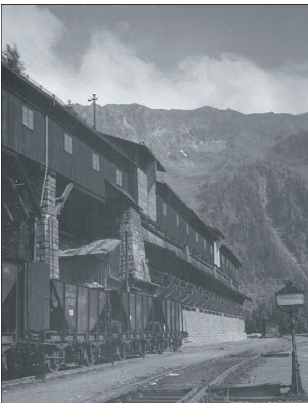
Abb. 8: 1891 in Betrieb genommene Erzverladeanlage bei der Station Erzberg der Zahnradbahn Eisenerz-Vordernberg. Mit 1931 datierte Aufnahme, Sammlung H. J. Köstler (Nachlass Wilhelm Schuster).
