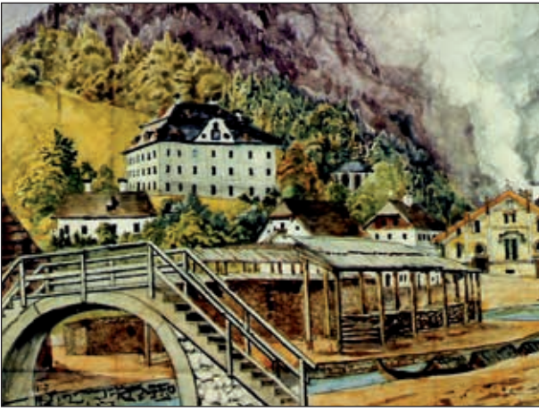
Abb. 15a: Betriebsgelände in der Lahn (Amtshaus, Hafen, Sudhaus)
