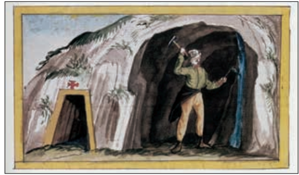
„Stehende Kluft“ (ungefähr senkrechter Erzgang)
