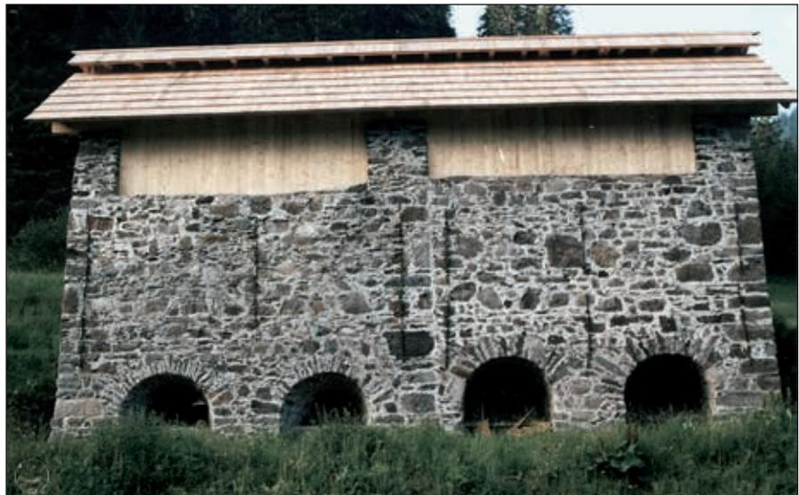
**Abb. 13:** Vorderfront der Röstanlage bei der „Franzenshütte“ in Bundschuh; je zwei Gewölbe für das Abziehen des Rösterzes in der älteren (erbaut um 1840, rechts) in der jüngeren Ofengruppe (erbaut 1862/64).
