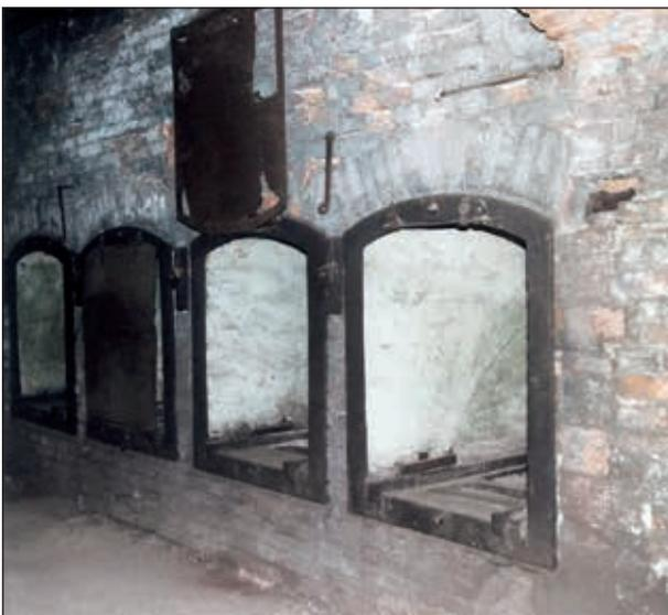
**Abb. 8: Beschickungsöffnung der Röstöfen im Radwerk IV; oberer Boden.**
