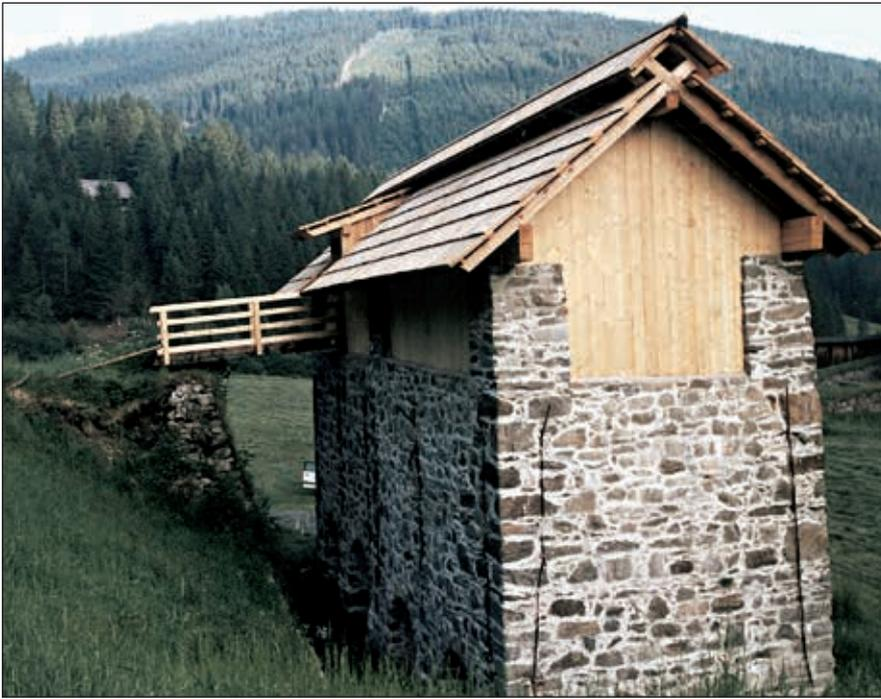
**Abb. 12:** Restaurierte Röstanlage mit vier Schachtöfen (vgl. Abb. 14) bei der „Franzenshütte“ in Bundschuh (Salzburg); links Brücke (Gichtsteg), ursprünglich für Erz- und Kohlenzufuhr auf die Gicht.
