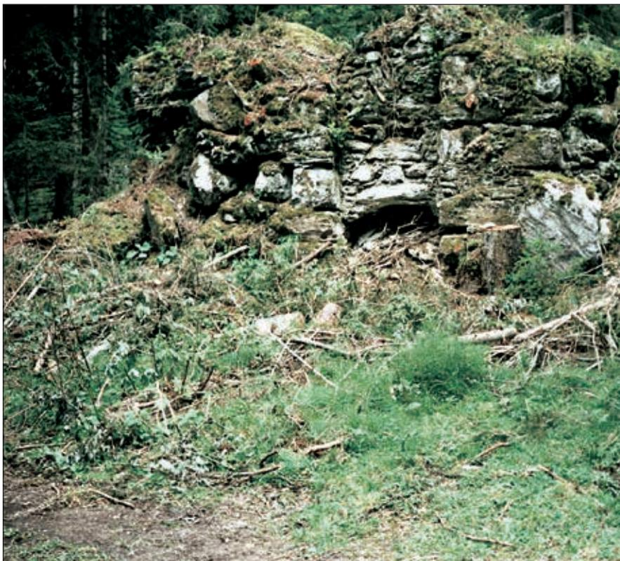
Abb. 15: Reste des Röstofens („Schwefelofen“, Bauart „Röststadel“ im Gegensatz zu einem „Schachtofen“) beim Kupfer- und Edelmetallbergbau in der Walchen bei Öblarn (Steiermark), erbaut um 1700 und stillgelegt 1858.
