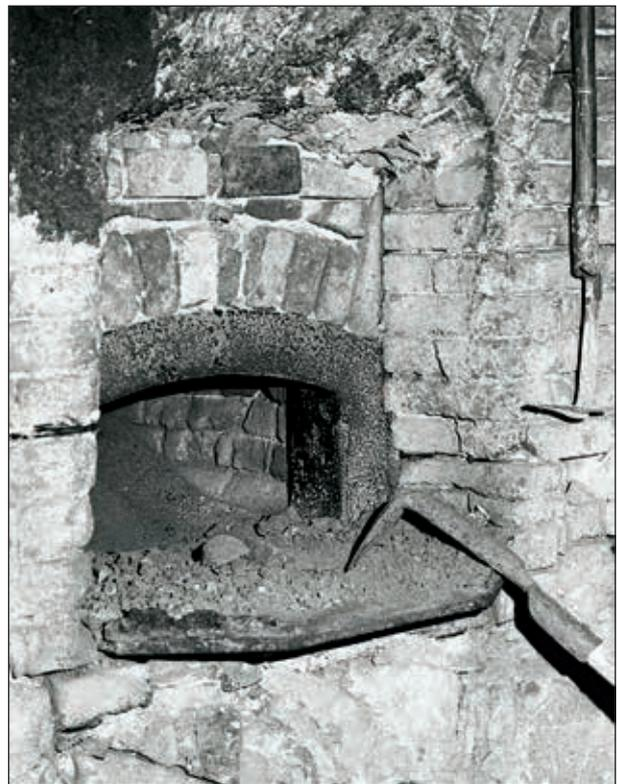
**Abb. 9: Abziehöffnung mit Koberbank eines Röstofens im Radwerk IV; unterer Boden.**
