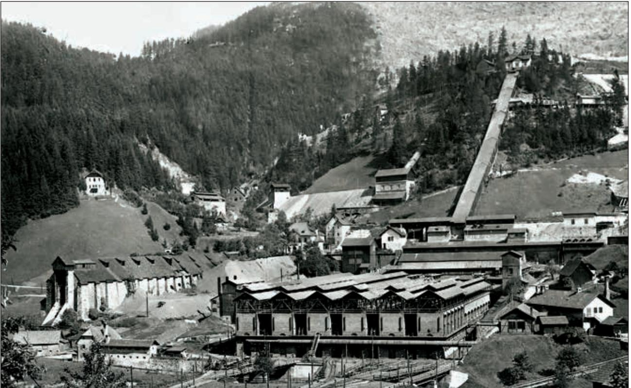
*Abb. 10: Röstanlage mit sechs Batterien im Krumpental (Münzboden) in Eisenerz am Fuß des Steirischen Erzberges (Steiermark), 1920. Links Erzmagazin „Syboldhalde“. Aufnahme im Bildarchiv H. J. Köstler*
