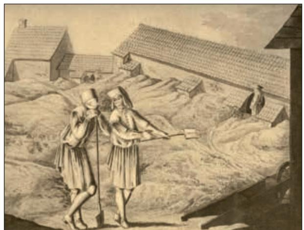
**Abb. 9:** Arsenikgewinnung aus dem Hüttenrauch.<sup>31</sup>
