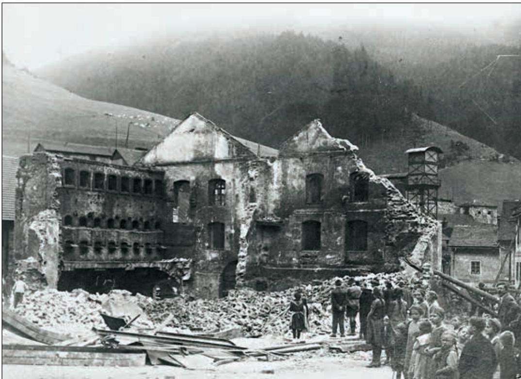
*Abb. 6: Abtragung des Vordernberger Radwerkes II im Jahre 1926. Links Reste der Röstanlage (System Fillafer); rechts im Hintergrund Turm des Roheisenaufzuges beim Radwerk III. Aufnahme im Archiv des Vereines Freunde des Radwerkes IV in Vordernberg*
