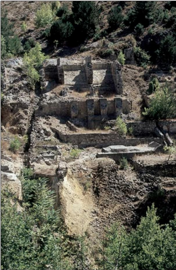
**Abb. 3: Reste von Erzkästen und Fülltrichtern beim Bergbau in Balya.**
