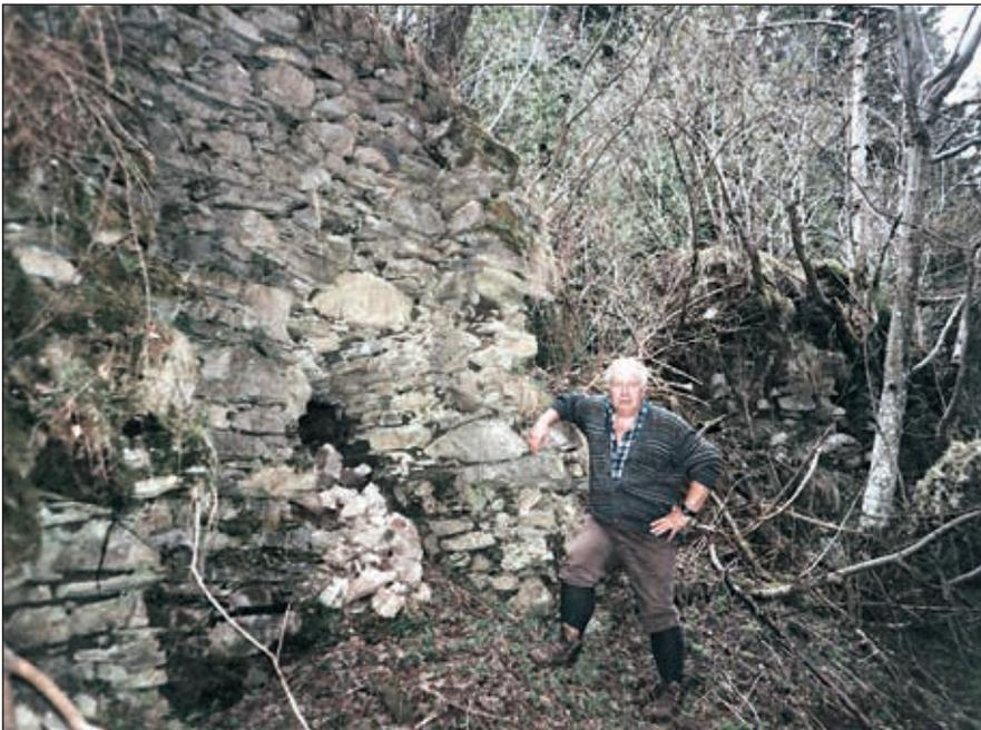
**Abb. 17:** Ruine des Röstofens (Röststadel) beim Pyrit- und Kupfererzbergbau nahe St. Peter am Kammersberg (Steiermark).
