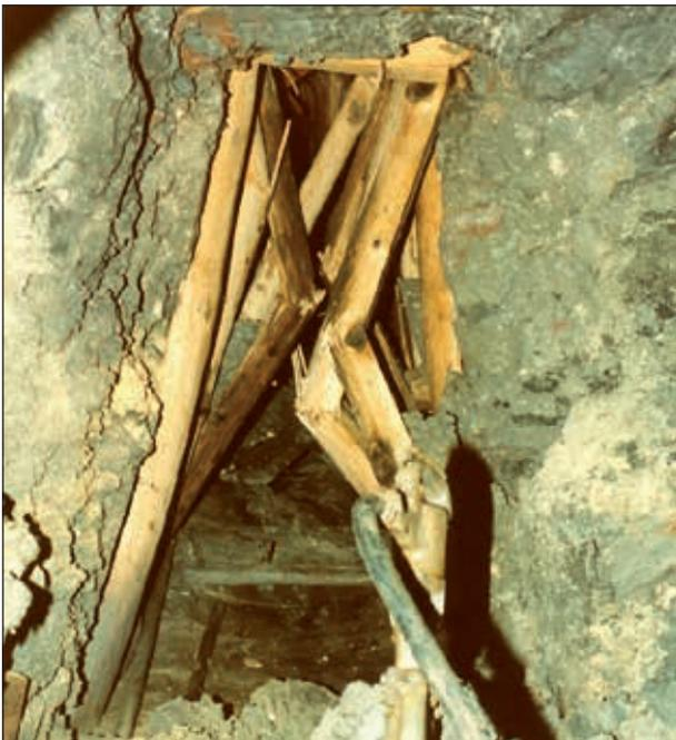
*Abb. 19: Vom Gebirgsdruck zerstörter Ausbau*
