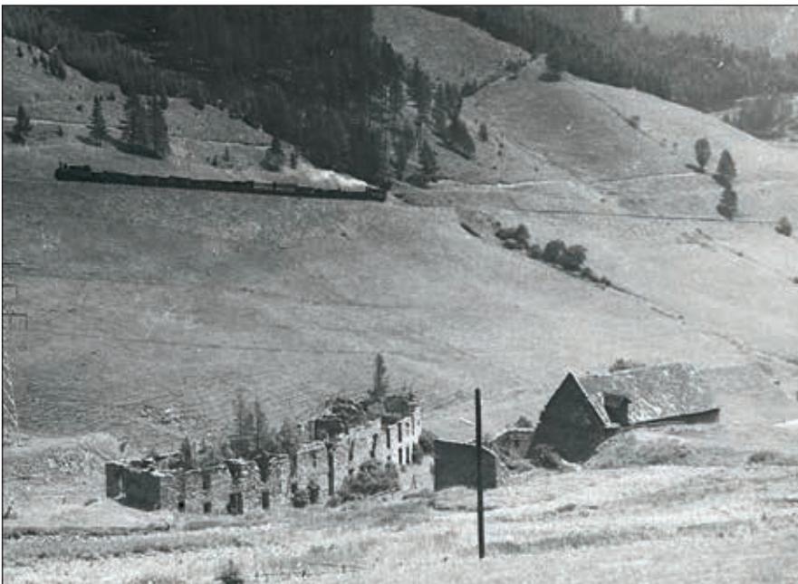
**Abb. 5:** „Laurenzi-Röst“ bei der St. Laurentius-Kirche („Laurenzi-Kirche“) in Vordernberg (Steiermark). Im Vordergrund links die Röstanlage, rechts Kohlbarren; im Hintergrund talwärts fahrender Erzzug mit zwei Zahnrad-Dampflokomotiven.
