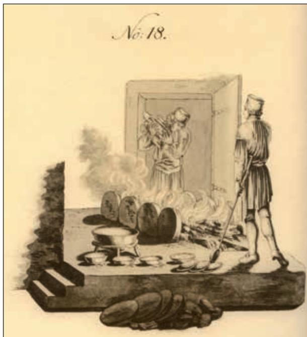
**Abb. 8:** Saigern von Schlacken der Farbglassherstellung zur Bismutgewinnung.<sup>31</sup> Neben der Schöpfkelle liegen kleine runde „Wismutbrote“.
