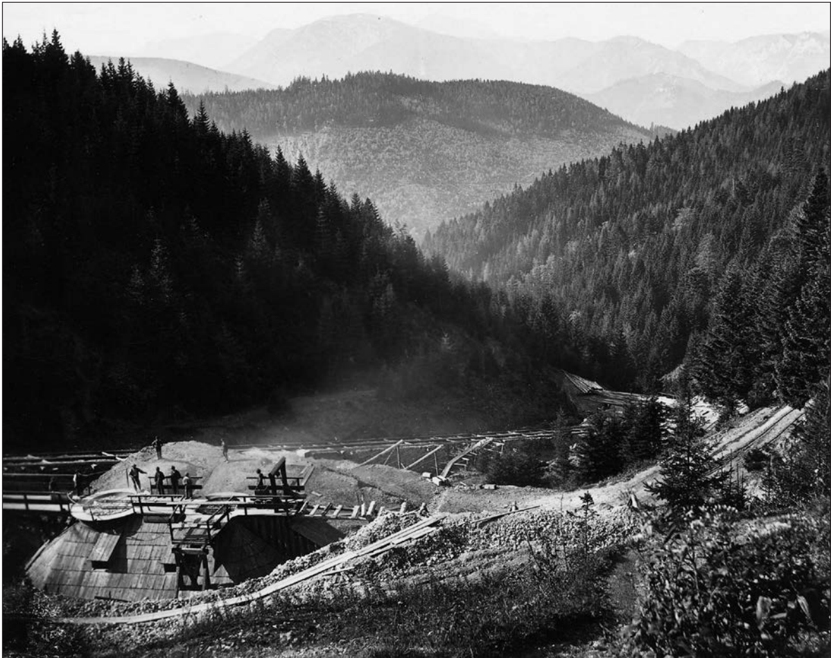
Abb. 15: Bergbau Sohlen am Niederalpl, um 1878/79. Im Vordergrund links zwei Röstöfen (nur Gicht sichtbar) in einer Rösthütte.
