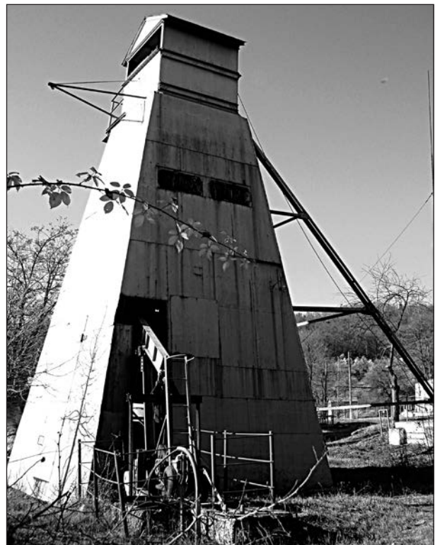
Abb. 4: Holzeingehauster Förderturm mit Pumpenbockantrieb
