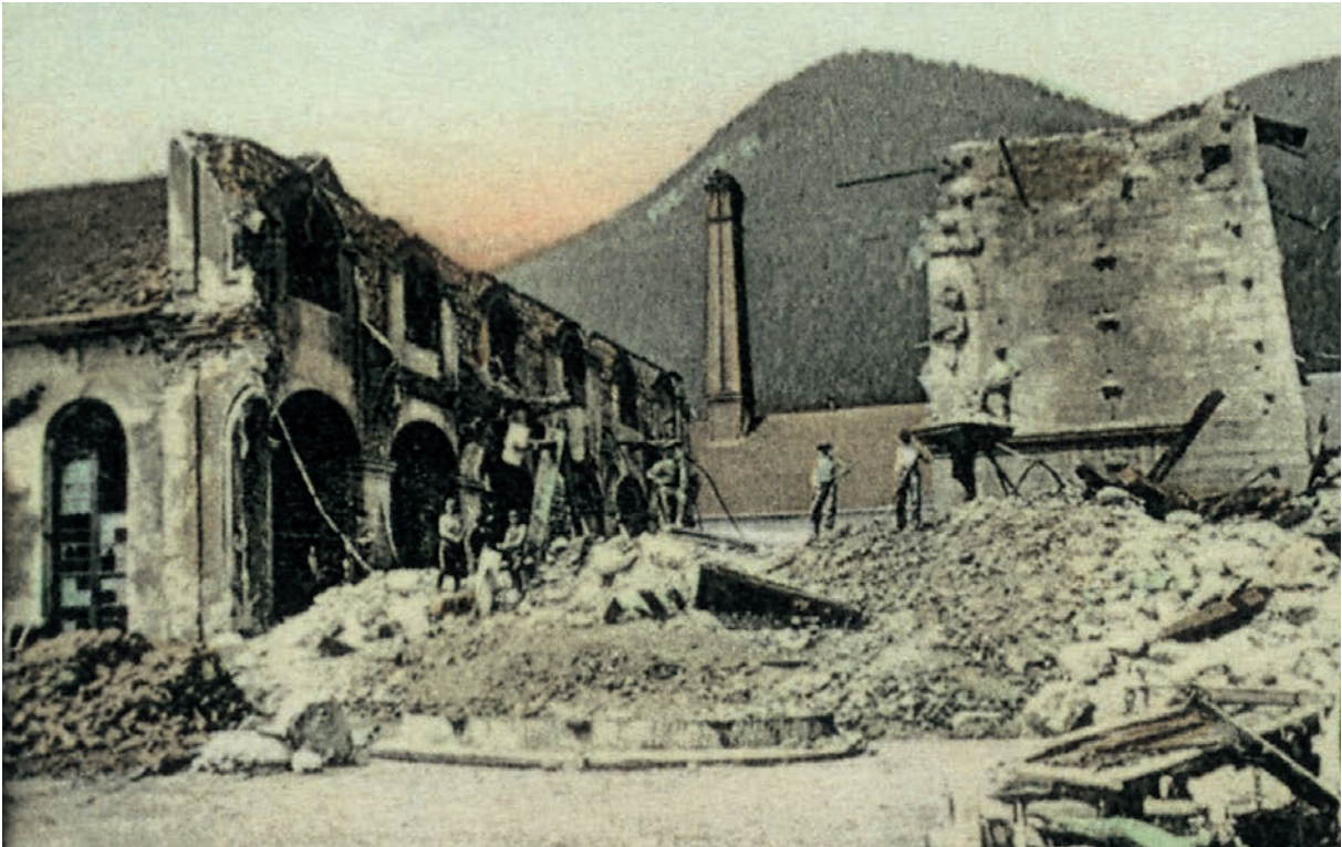
Detail einer am 8. Juli 1907 geschriebenen Ansichtskarte (Sammlung Hans Kolb, Bruck a. d. Mur): „Demolierung der Gusshütte“ in Gusswerk bei Mariazell.
