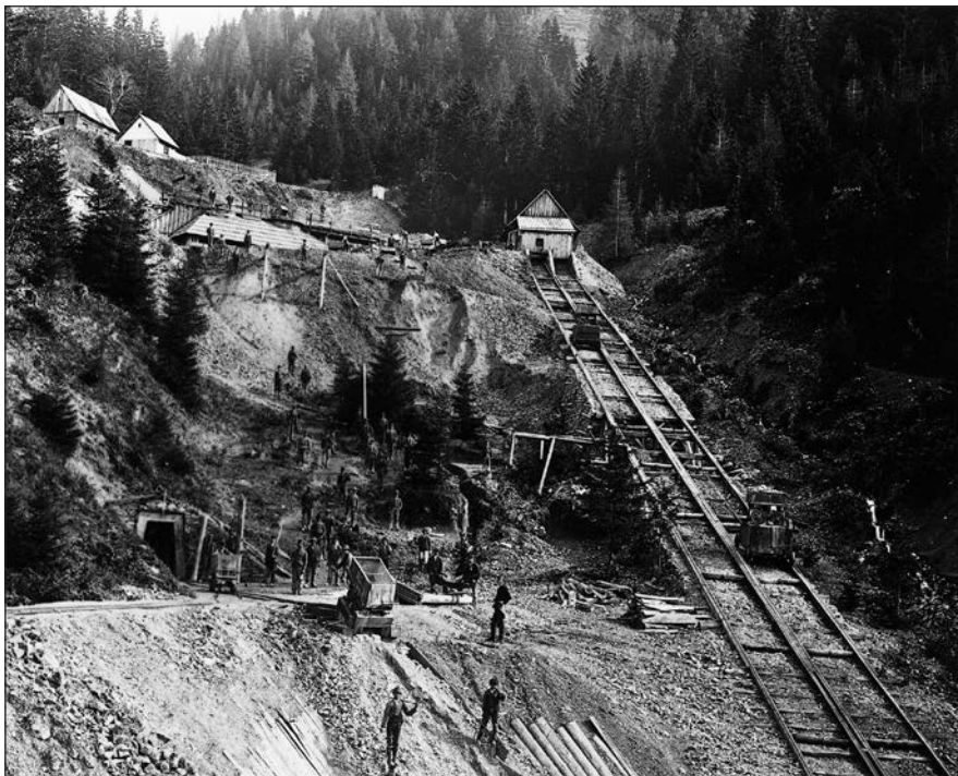
Abb. 14: Bergbau Sohlen am Niederalpl, um 1878/79. Rechts Schrägaufzug für Erztransport, links zwei Erzröstöfen (nur Gicht sichtbar) in einer Rösthütte (auf Höhe der Kopfstation des Aufzugs); links oben Berghaus, links unten Mundloch des Antonistollens.
