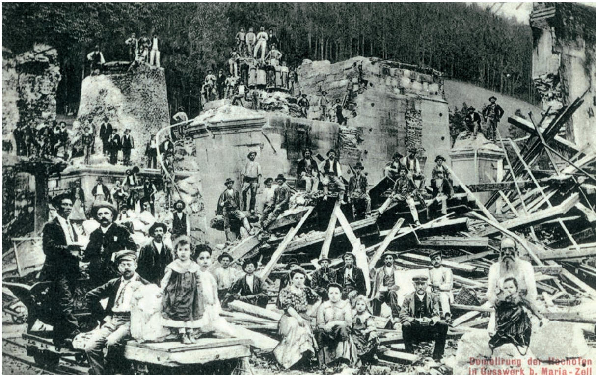
Aufnahme wahrscheinlich am 11. Juli 1907 (Sammlung Hans Kolb, Bruck a. d. Mur): „Demolierung der Hochöfen in Gusswerk b. Maria-Zell“.
