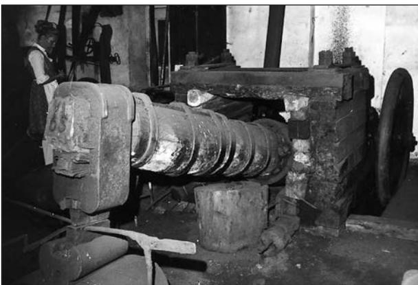
**Abb. 16: Mitterlobming. Schwanzhammer (nicht mehr durch ein Wasserrad angetrieben) im Hammerwerk Gruber.**
