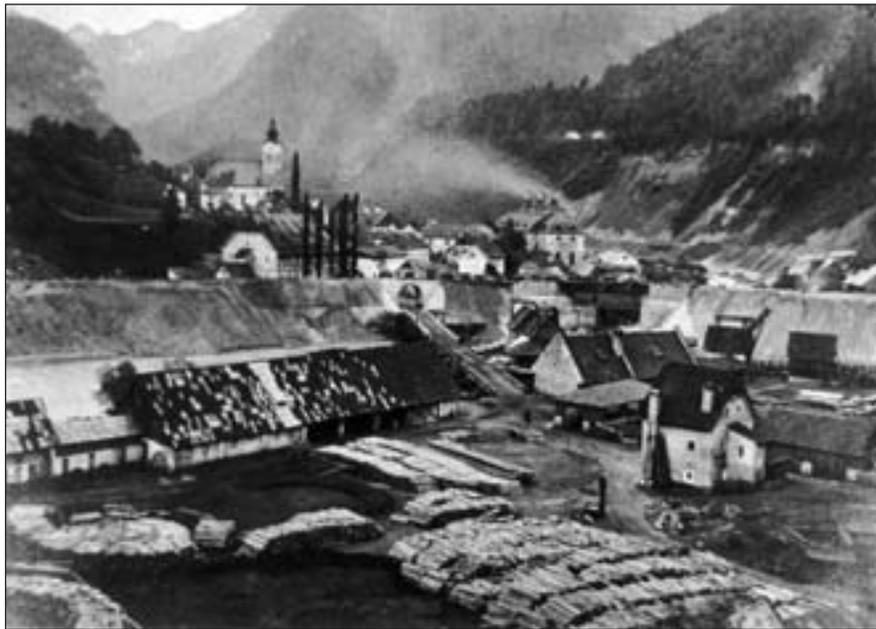
**Abb. 5:** Auf dem Foto um 1875 sieht man im Vordergrund auf der Lend die aus dem Rechen von Hiefrau mittels Kran (im Mittelgrund sichtbar) herausgehobenen Stämme, die dann verkohlt wurden. Die Holzkohle wurde in die Hochöfen im Hintergrund gegichtet.
