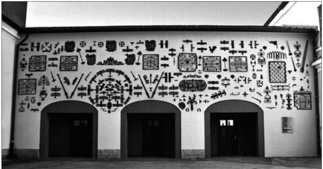
Schmiedeeisenobjekte an der ehemaligen Stiftsschmiede in Admont
