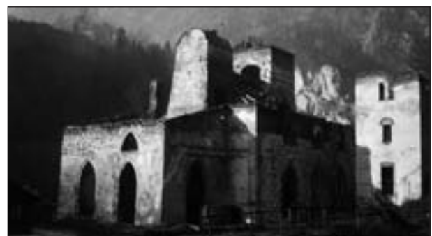
Abb. 7: Hieflau. Reste des Hochofenwerkes am 13. Dezember 1938. Links: altes Gebläsehaus; Mitte: „Ludovica“- (links) und „Franz Josef“-Holzkohlenhochöfen; rechts: Holzkohlenaufzug. (Kokshochofen 1931/32 abgetragen). Aufnahme: Archiv H. J. Köstler
