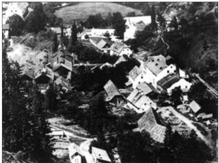
Abb. 26: Trieben Stahl- und Blechwalzwerk „Benedictshütte“ des Stiftes Admont (früher einer Kommanditgesellschaft), Hüttenanlage im Wolfsgraben links im Bild; um 1905/6. Aufnahme: Archiv H. J. Köstler
