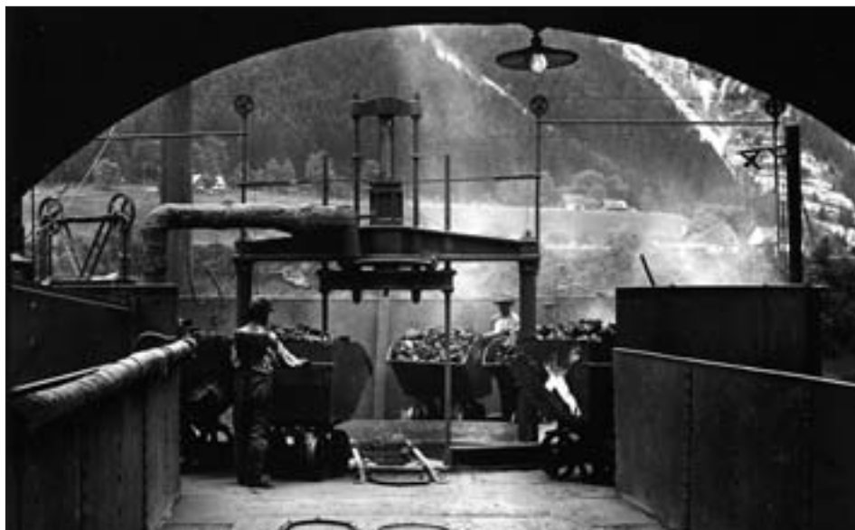
Abb. 6: Hieflau. Gichtplateau des 1887 angeblasenen und 1923 ausgeblasenen Kokshochofens, Hunte mit Rösterz oder Koks; um 1905 (?). Aufnahme: Archiv H. J. Köstler (Nachlass W. Schuster)
