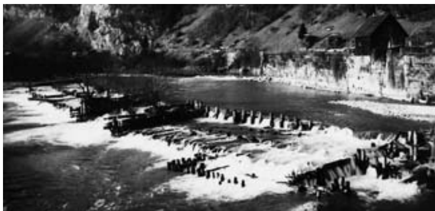
Abb. 2: Hieflau. Reste des Holzrechens (Hauptrechen) in der Enns, um 1930 (?). Rechen von 1572 bis 1891 in Verwendung, 1906 großteils abgetragen. Aufnahme: Archiv H. J. Köstler (Nachlass W. Schuster)
