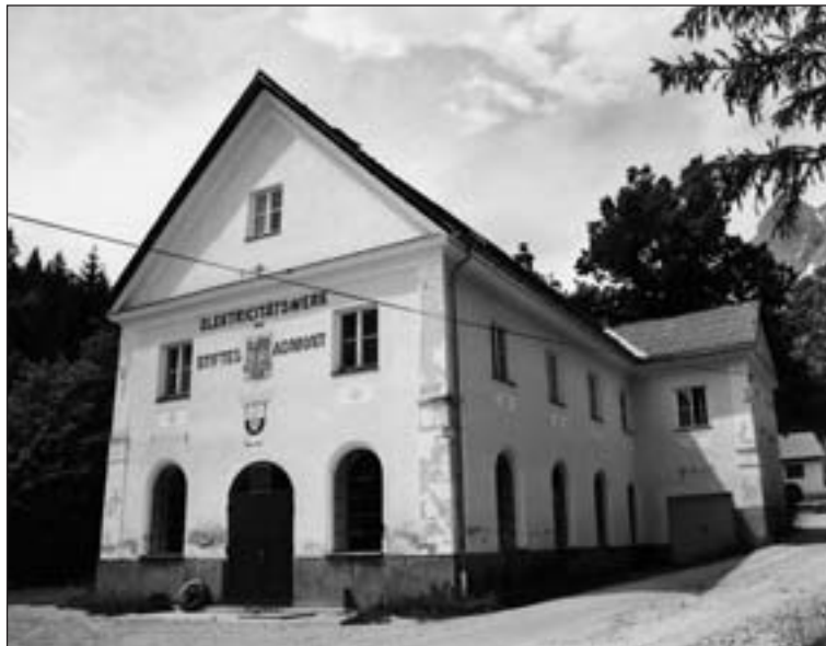
Abb. 12: Mühlau, Gemeinde Hall bei Admont. Ehemaliges Werksgebäude der Gewerken Liebl, jetzt E-Werk des Stiftes Admont. Aufnahme: H. J. Köstler, Mai 2008
