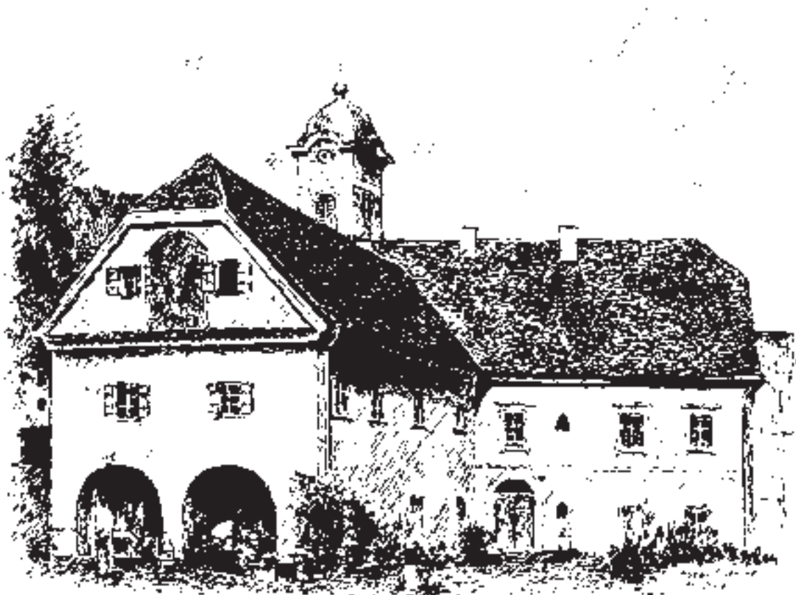
Wasserleith bei Knittelfeld. Herrenhaus des 1910 als mechanische Werkstätte stillgelegten, ehemals bedeutenden Weinmeisterischen Sensenwerkes; das beachtenswerte, bestens restaurierte Gebäude dient heute als Wohn- und Pflegeheim der Caritas.
