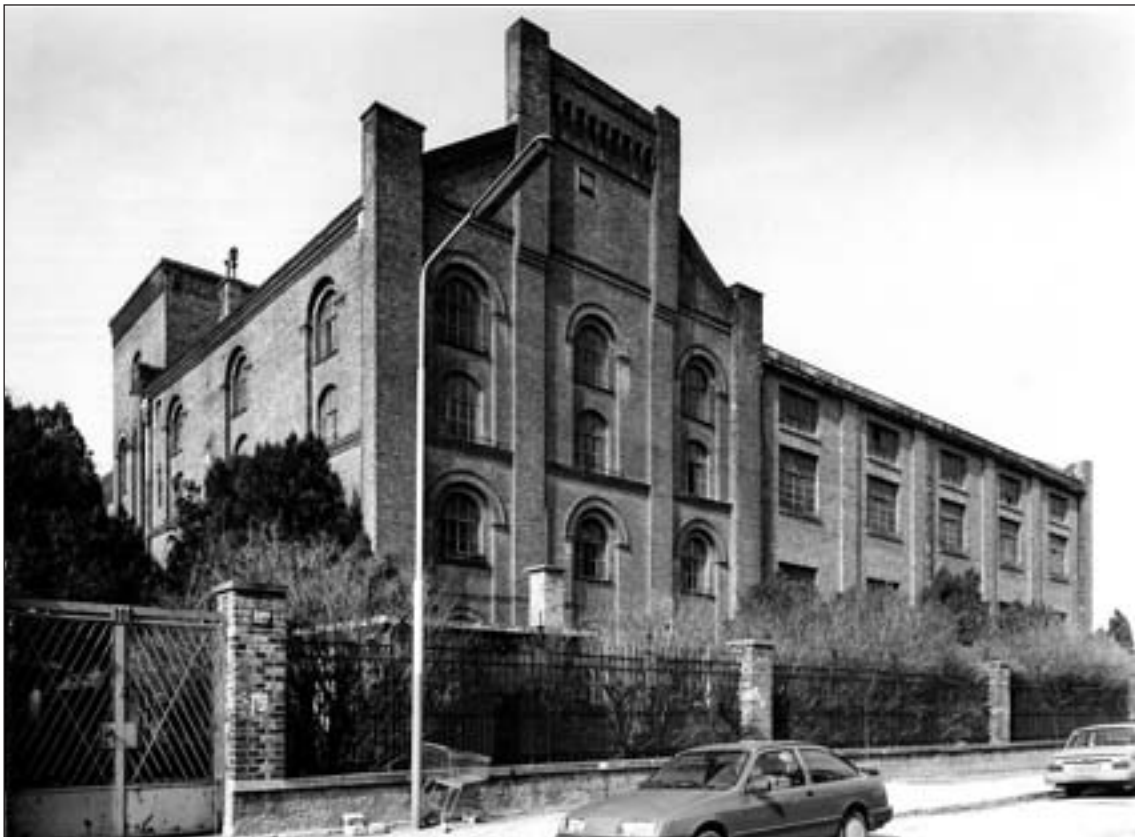
Abb. 6: Wien 19, Muthgasse 109: Errichtet 1897 als E-Werk (Dampfmaschinen) zur Stromversorgung der Beleuchtungseinrichtungen der Stationen der Wiener Stadtbahn (Betrieb mit Dampflokomotiven!). Später Lehrwerkstätte der ÖBB. Ab 1987 Umgestaltung zu einem Bürohaus. Technisches Denkmal: Typische Industriearchitektur der Zeit 1886-1905.
