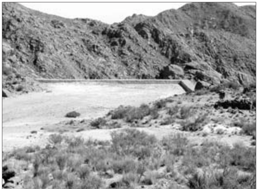
Abb. 7: Auffangbecken zur Sammlung von Regenwasser im Bereich der Erzgänge La Grande und La Rosario ; Aufnahme H. PUTZ, November 2005.
