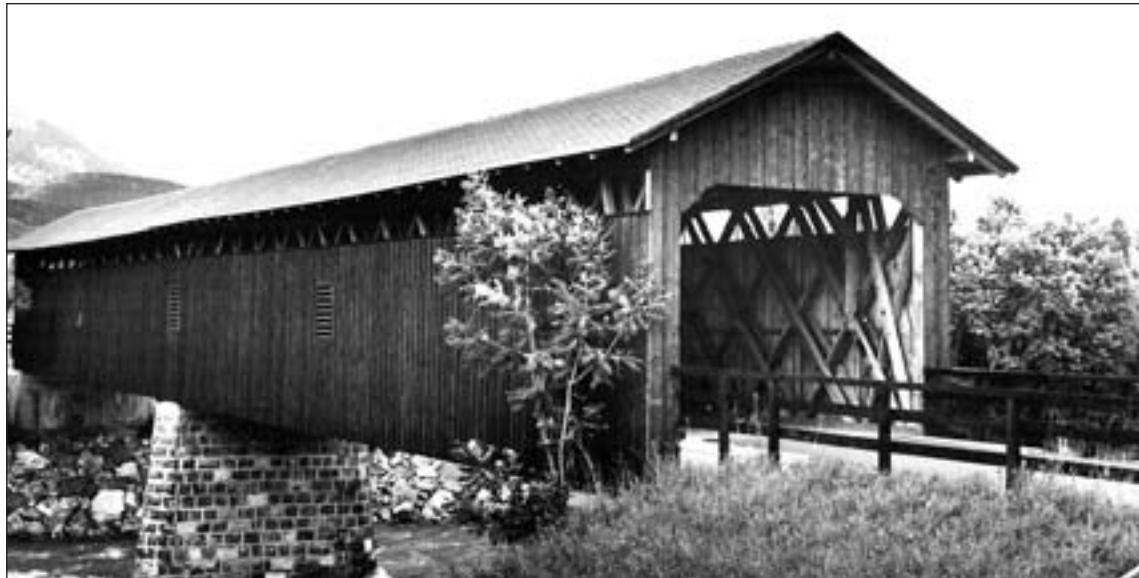
Abb. 1: Nenzing – Bludesch, Vorarlberg: Illbrücke. Teil der ehemaligen, 5-teiligen Rheinbrücke von Mäder nach Krissern in der Schweiz. Errichtet 1870/80 als sogenannte Howe'scher Träger. Technisches Denkmal: Eine der einst zahlreichen Vorarlberger gedeckten Holzbrücken, die für die Landschaft prägend sind. Da derartige Konstruktionen den heutigen Verkehrserfordernissen meist nicht mehr gewachsen sind, wurden in den letzten Jahren mehrfach solche Brücken an andere Orte versetzt, wo sie für Radfahrer- und Fußgängerverkehr weiter genutzt werden.
