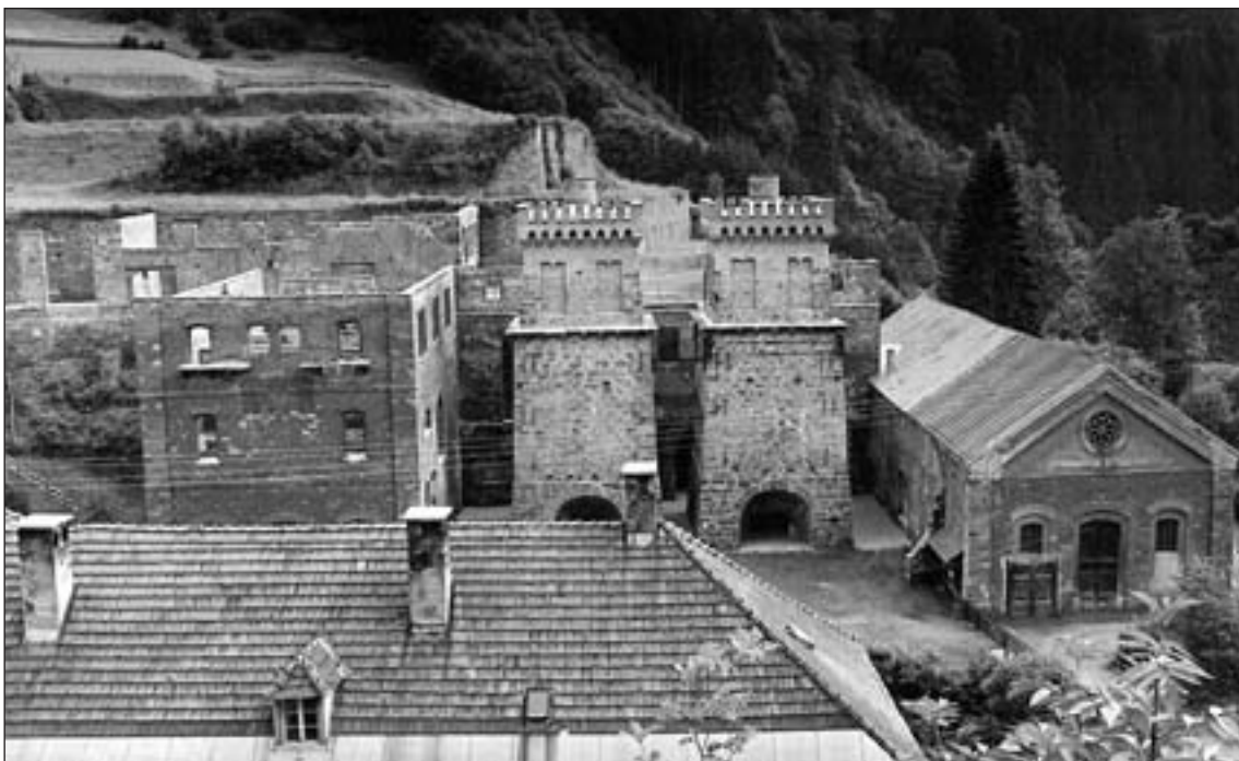
Abb. 8: Heft, Kärnten: Hochofenanlage, errichtet ab 1857, stillgelegt bis 1908. Technisches Denkmal: Auch im ruinösen Zustand imposante Anlage mit Bremsberg, Umladestation, Hangtrasse, Erzbunker, Terrasse der ehemaligen Röstöfen, Kohlbarren, 2 Hochöfen, Gebläsehaus und weiteren Nebenobjekten. Denkmalschutz 1983, Restaurierung als Freilichtmuseum. 1995 erfolgten zur Durchführung der Kärntner Landesausstellung gravierende Zu- und Umbauten, die die Anschaulichkeit der Anlage unnötig beeinträchtigen.
