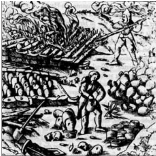
Abb. 4: Anlage einer Quecksilberverhüttung mit Retorten. Aus H. Valentinitich (16), S. 24.
