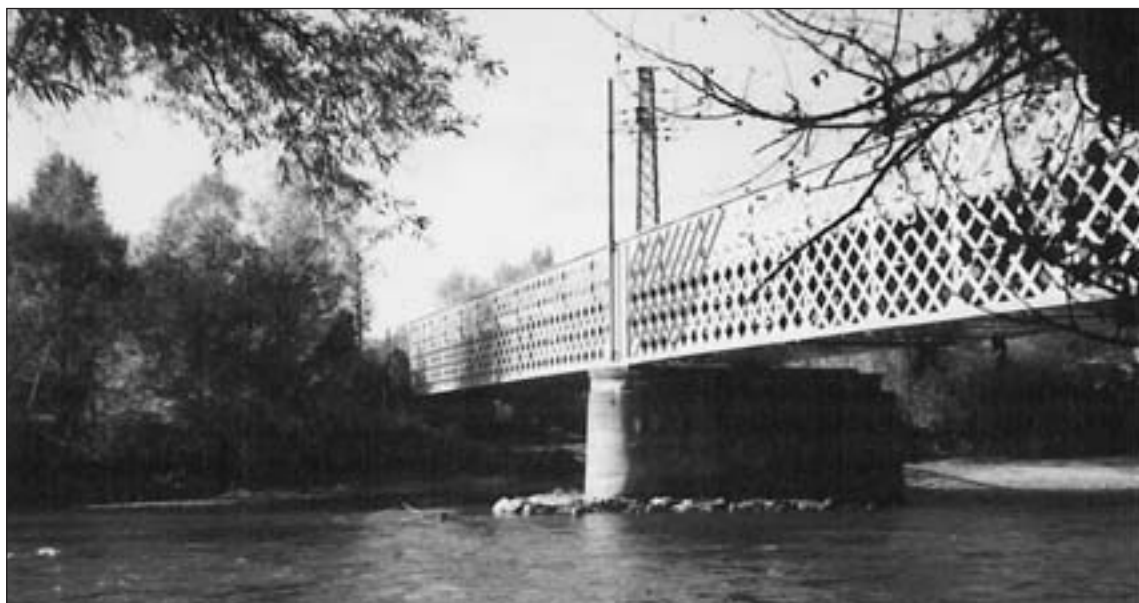
Abb. 2: Peggau, Steiermark: Murbrücke der Lokalbahn Peggau – Übelbach. Errichtet 1862 für die Südbahn. Das System der Gitterträger wurde ab 1848 im Ausland entwickelt und in Österreich vielfach angewendet. Technisches Denkmal: Letztes erhaltenes Beispiel dieser historischen Konstruktionsart und älteste Stahlbrücke Österreichs.
