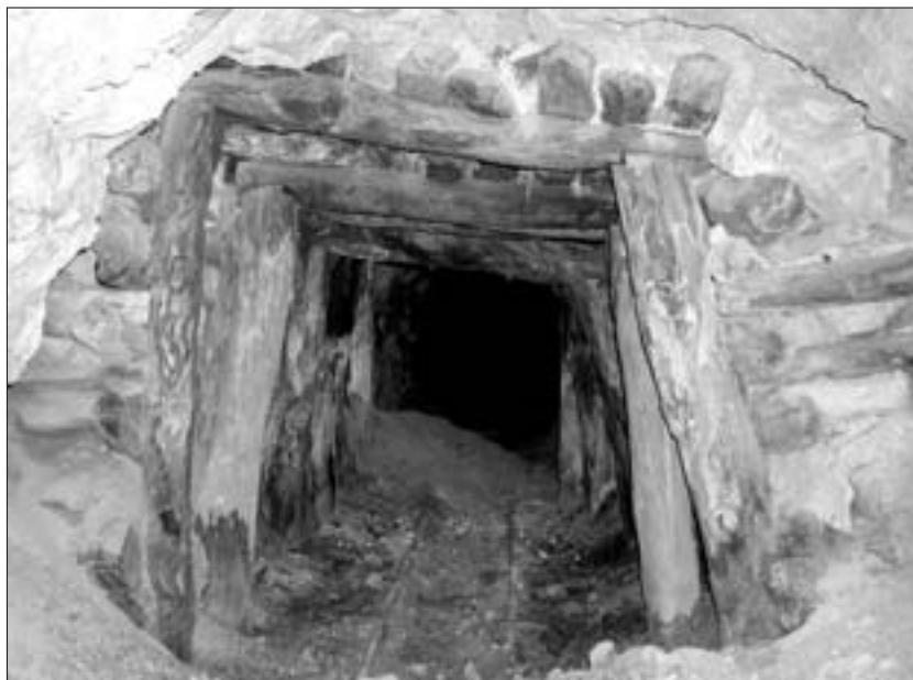
Abb. 5: Mundlochbereich der alten Grube San Salvador mit Zimmerung aus Algarrobenholz ; Aufnahme H. PUTZ, November 2005.
