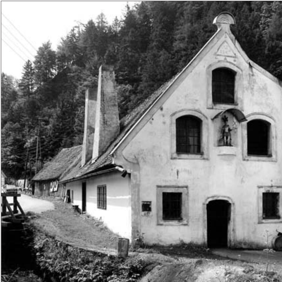
Abb. 9: Ybbsitz, NÖ: Fahrngruber-Hammer. Ehemalige Hackenerzeugung, erbaut 1847, vor einigen Jahren stillgelegt mit komplett erhaltener Einrichtung. Heute Schmiedemuseum mit Schmiedekursen. Im Hintergrund der zugehörige Kohlbarren. Technisches Denkmal: Anschauliches Beispiel frühindustrieller Produktionsweisen, wie Abb. 10 veranschaulicht.
