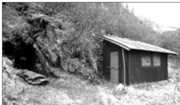
Abb. 17: Grubenhütte und Mundloch des Unterbaustollens in der Krumpfen, Okt. 2008. Aufnahme: J. Friml (s. Seite U4)
