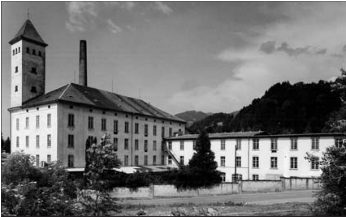
Abb. 5: Rankweil, Vorarlberg: Ehemalige Spinnerei Franz Rhomberg. Errichtet 1839 als viergeschossiger geschlossener Baukörper mit Walmdach, 1889 Erweiterungsbauten, 1910 Wasserturm. Heute als Gewerbepark genutzt. Technisches Denkmal: Repräsentatives Beispiel aus der Frühzeit der Vorarlberg prägenden Textilindustrie.
