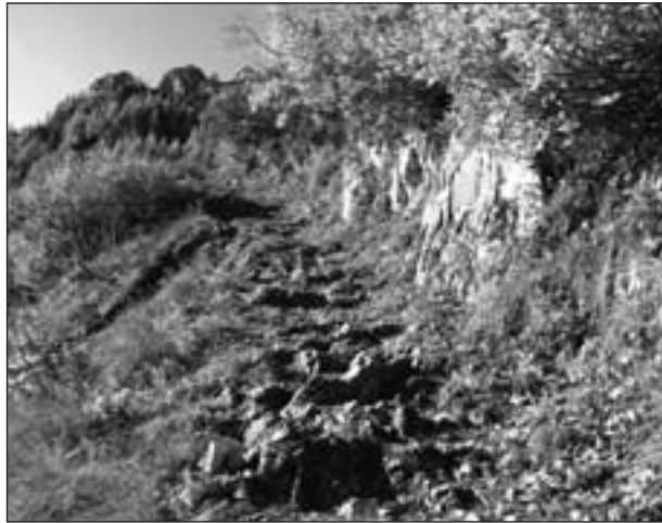
Abb. 10: Transportstraße (fertiggestellt 1839) zum Unterbaustollen in der Krumpen, September 2007. Aufnahme: J. Friml (siehe Seite U4).
