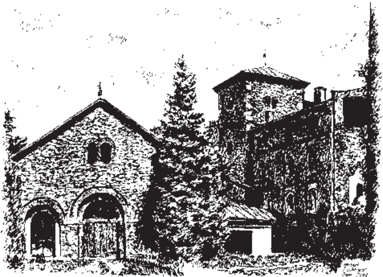
Vordernberg. Radwerk I, auch als Peintinger-Hochofen bekannt; für 1578 nachweisbar, 1862/63 zeitgemäßer Neubau, 1907 Auflassung der Roheisenproduktion. Rechts: Erzröstanlage und Gichtturm, links: Gießhalle; der Hochofen zwischen diesen Bauten wurde um 1910 abgetragen.
