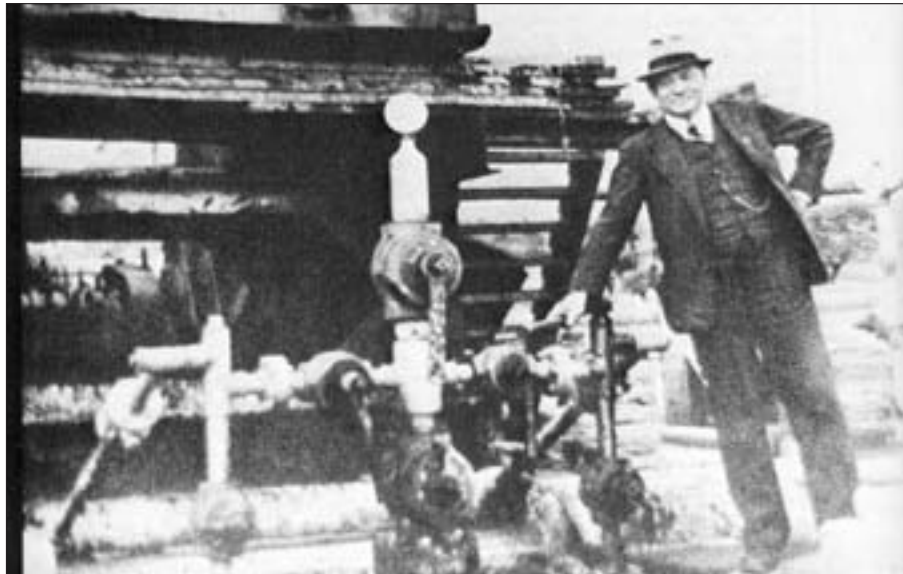
Abb. 5: Ing. Friedrich Musil auf der Bohrung „Prinzendorf I“, gestützt auf das Produktionskreuz.
