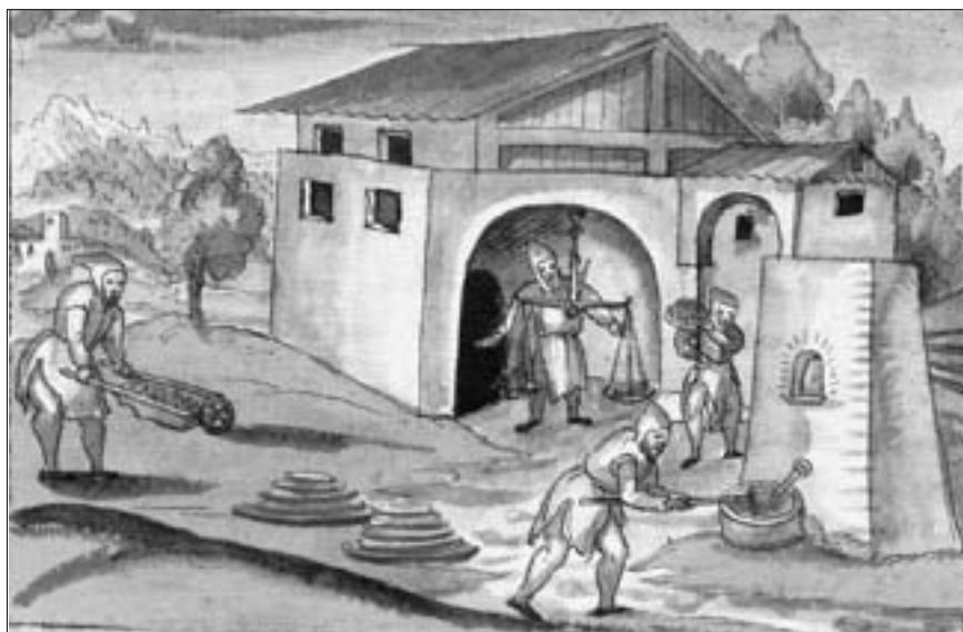
Abb. 4: Hüttenschlag mit Schmelzofen und Wägen von Erz und Zuschlägen (Faksimileausgabe des Schwazer Bergbuches, Codex 10.852).
