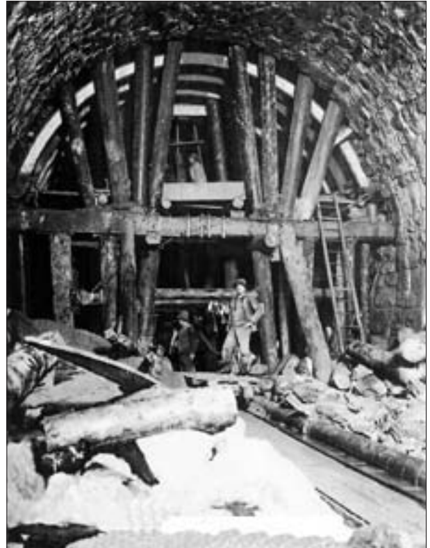
Abb. 1: Bau des Tauerntunnels zwischen Böckstein und Mallnitz der Eisenbahnstrecke Schwarzach – Spittal a. d. Drau (Tauernbahn), Aufnahme ca. 1905.
