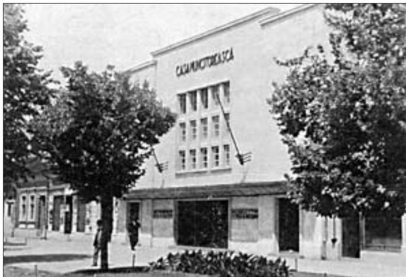
Das zu Beginn der 1930er Jahre in der Reschitzer Altstadt erbaute Arbeiterheim.
