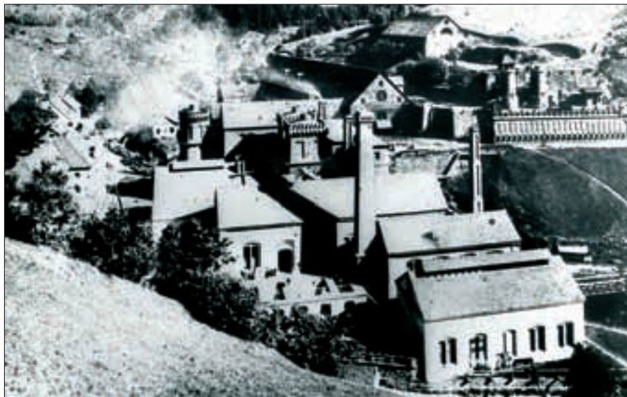
Abb. 4: Eisenhütte der ÖAMG in Heft beim Hüttenberger Erzberg um 1890. Rechts oben: Erzbunker, rechts davor zwei (runde) Schwedische Erzröstöfen und Fillafer'sche Erzröstanlage; links der Röstanlagen: Kohlbarren; in Bildmitte: Hochöfen „Johann-Ernst“ und „Pulcheria“, links dieser Hochöfen: Bessemerstahlwerk und (runder) Hochofen „Eduard“; vor den Hochöfen: Gebläsehaus, rechts davor Kesselhaus (mit zwei Kaminen), rechts vorne: Gebäude mit dem aus Mosinz überstellten Gebläse. Undatierte Aufnahme im Bergbaumuseum Hüttenberg in Knappenberg.
