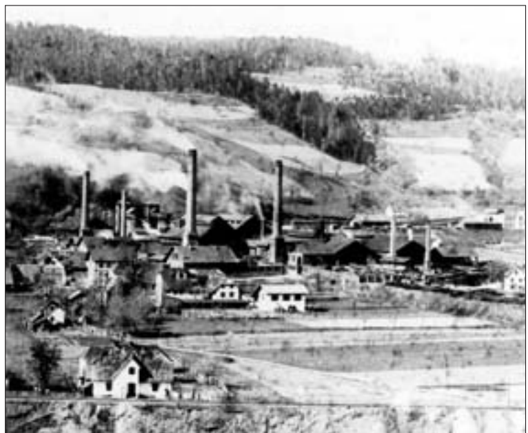
Abb. 3: Eisenhütte (Neues Werk) der ÖAMG in Prävali um 1890. Links: zwei Hochöfen (mit rundem Gichtplateau), rechts davor Bessemerstahlwerk, rechts daneben Grobblech-, Träger- und Schienenwalzwerk. Undatierte Aufnahme im Besitz von H. J. Köstler.
