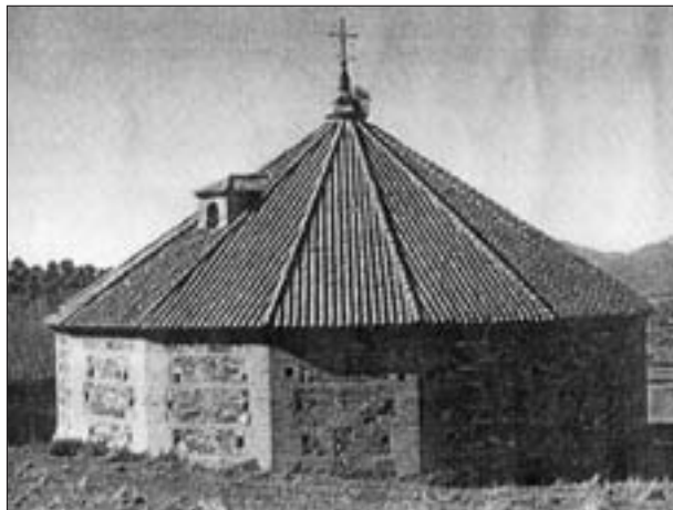
Abb. 12: Grube Concepción, Almadenejos. In diesem Gebäude befand sich ein mit Maultieren betriebenes Göpelwerk, mit dem das Erz aus der Grube gefördert wurde. Die Luft war so giftig, dass die Tiere nach einigen Stunden ausgewechselt werden mussten. Aus Betancourt, Memoires ... S. 39.
